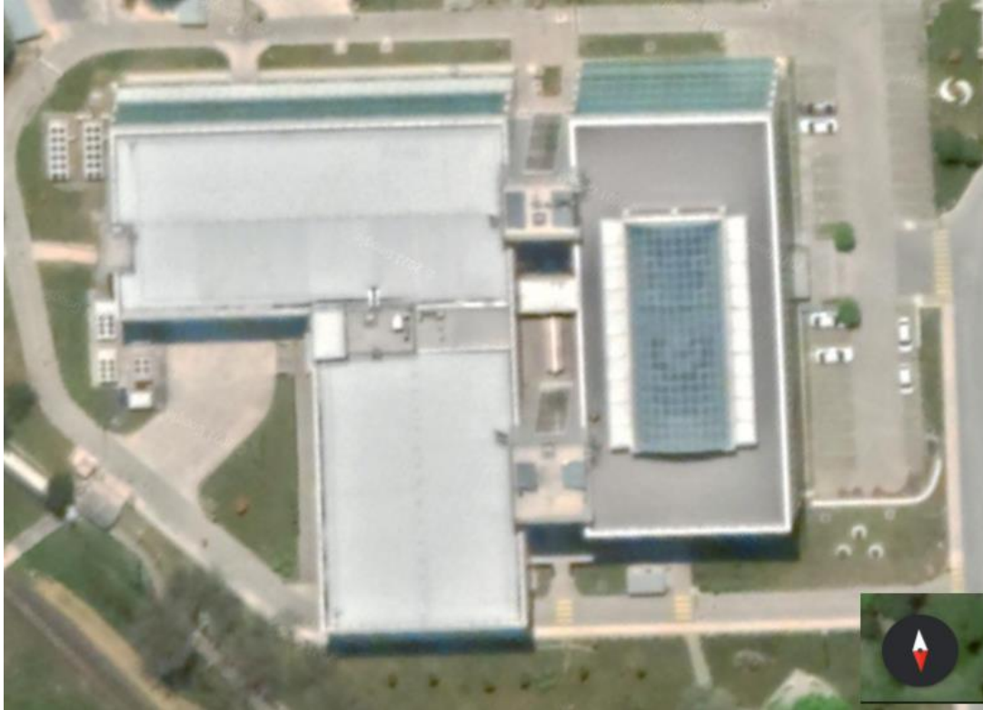
Şekil 4.3: Ofis binasının çatı alanı.
