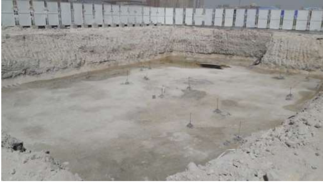
Şekil 4.7: Kazı yapıldıktan sonraki durum.
