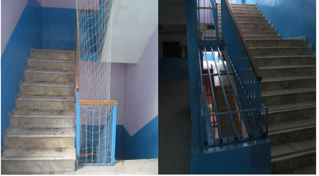
Şekil 4.1. Merdiven Korkulukları ve Boşlukları
