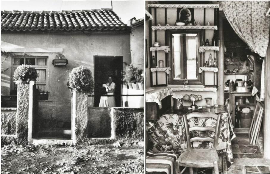
Şekil 2.38 II. Evre – Atina Kaisariani'de devlet eliyle yapılan bir konut ve iç mekanı (1950 veya 1951), (KAAM Arşivi), (Κοντογωργη, 2016), (Λιανός, 2016)
