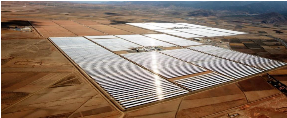
Şekil 3.1 Andasol-12 güneş termal santralleri
