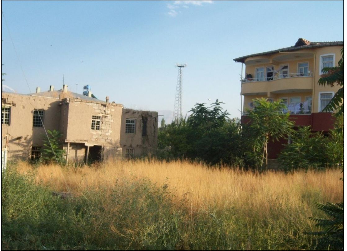
Foto 22: Ali Kamerli Mahallesi'nde eski ve yeni konutlardan bir görünüm, sağda modern yapılar solda ise kerpiç yapılar
