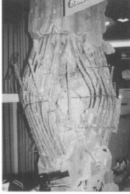
Şekil 3.1 : Kobe depreminin ardından bir yapıda gözlemlenen basınç kırılması [8].
