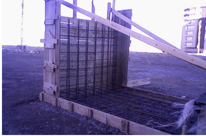
Şekil 5.1. Düşeyde perdeyi yatayda da döşemeyi temsil eden betonarme kalıp ve 25cm ara ile perde ve döşeme elamanına Ø16 donatı döşenmiş hali.
