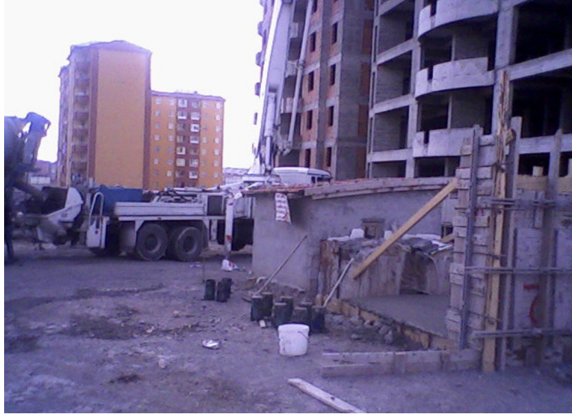
Şekil 5.3. Döşeme ve perde betonu kalıba yerleştirilmesinin akabinde alınmış olan silindir numunelerin görünümü.
