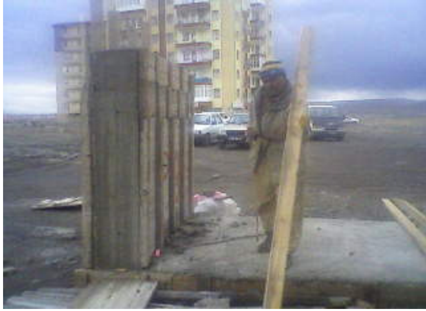
Şekil 5.10. Kalıpların sökölme aşaması.
