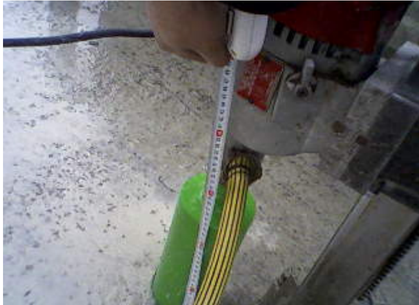
Şekil 5.14. Döşeme elemanından karot alırken yakından görünüm.
