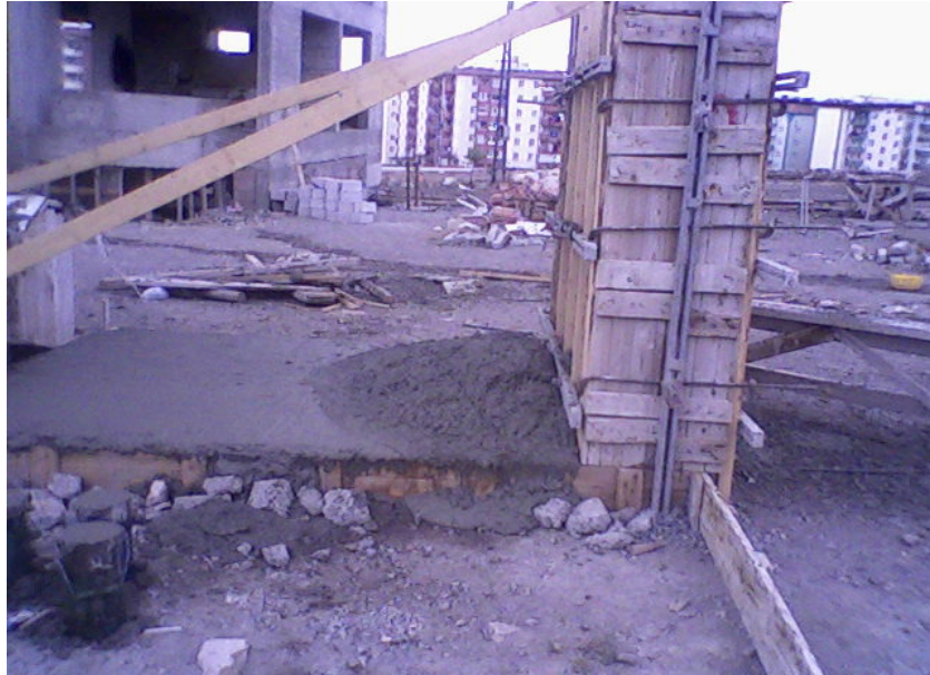
Şekil 5.6. Perde betonunun kalıba yerleştirilmesi sırasında döşeme yönünde beton akışı.
