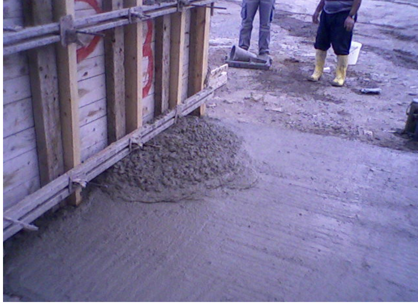
Şekil 5.5. Perde betonunun kalıba yerleştirilmesi sırasında döşeme yönünde beton akışı.
