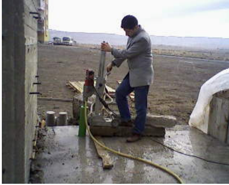
Şekil 5.13. Döşeme elemanından karot alınırken.
