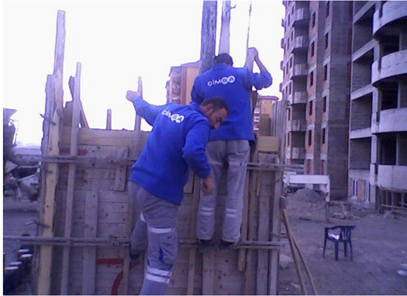
Şekil 5.4. Perde betonunun kalıba yerleştirilmesi ve sıkıştırma işlemi yapılırken.
