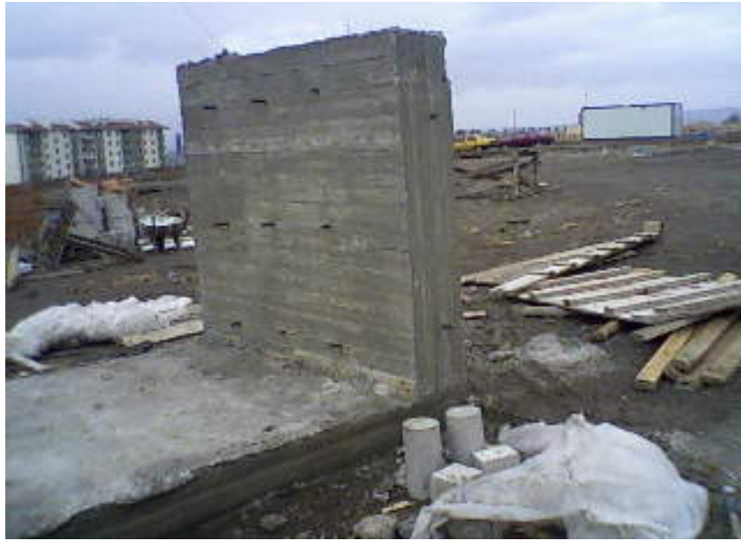
Şekil 5.11. Kalıptan söküldükten sonra özel üretilen betonarme ünite ile birlikte, iki adet silindir ve iki adet küp numuneleri çevre koşullarına maruz bırakıldı.
