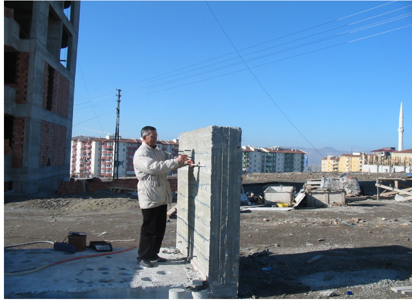
Şekil 5.28. Perde betonunda karot alınacak ve alınmadan evvel ultrasonik hız okunması yapılacak yerlerin belirlenmesi.
