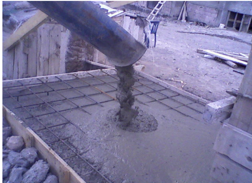
Şekil 5.2. Döşeme betonunun kalıba yerleştirilmesi.
