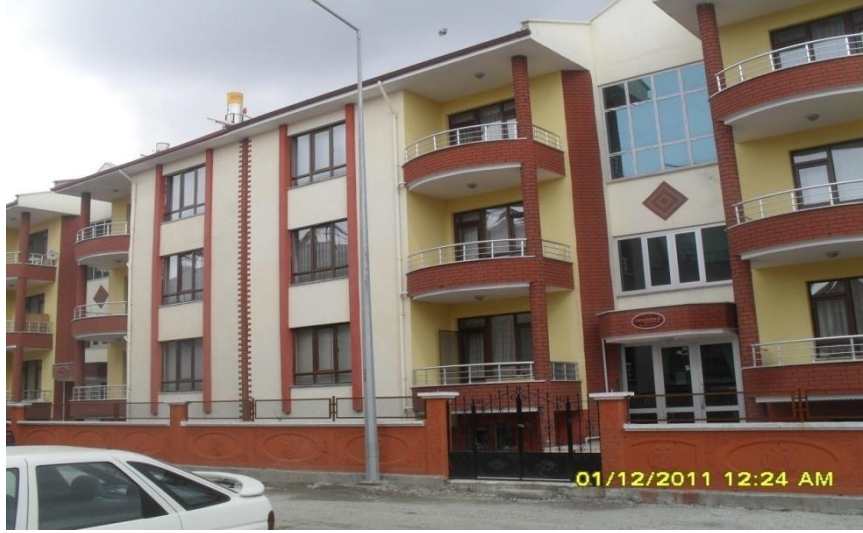
Şekil 5.3. Örnek 1'in ısı yalıtımı yapıldıktan sonraki cephesi
