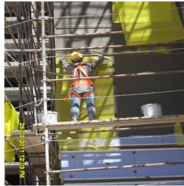
Şekil 4.21. Donatı filesinin ilk sıva katmanı üzerine uygulanması
