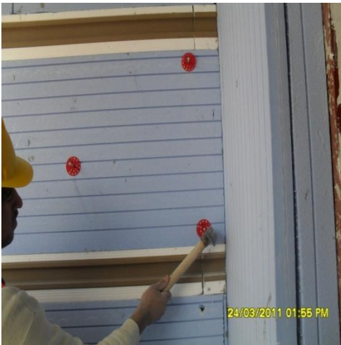
Şekil 4.17. Dübelleme işlemi yapılmaktadır
