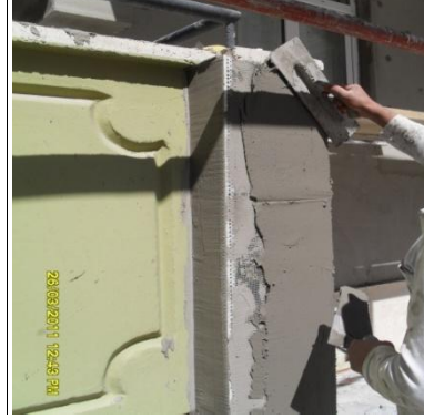
Şekil 4.22. İkinci kat sıva uygulaması
