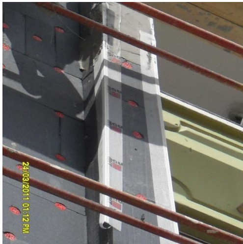
Şekil 4.18. Köşe profillerinin uygulanması
