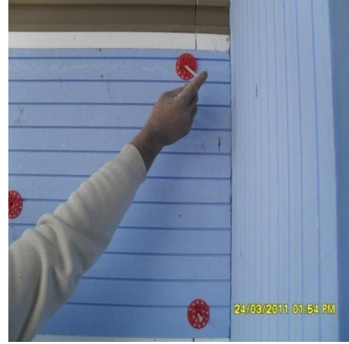
Şekil 4.16. Duvar ve ısı yalıtım levhası matkap ile delinmektedir
