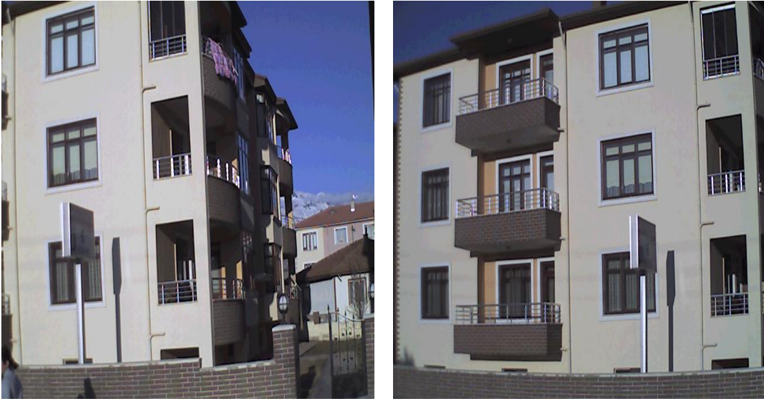
Şekil 5.24. Örnek 6'nın ısı yalıtımı uygulandıktan sonraki görünüşü
