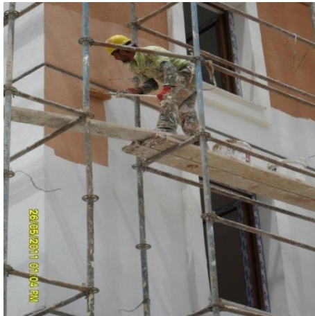
Şekil 4.9. Son kat dekoratif kaplama uygulaması
