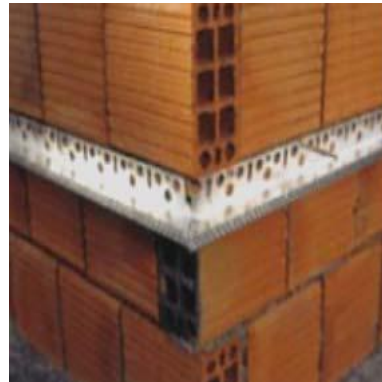
Şekil 4.12. Başlangıç profilinin duvara uygulanması (Karaca, 2007)
