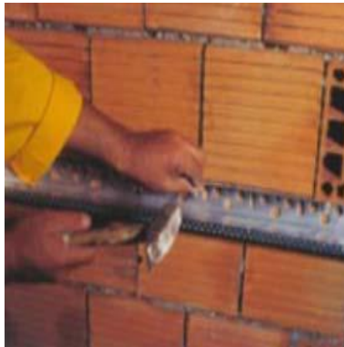
Şekil 4.12. Başlangıç profilinin duvara uygulanması (Karaca, 2007)
