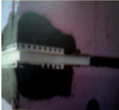
Şekil 4.19. Dilatasyon profillerinin uygulanması (Akıncı, 2007)
