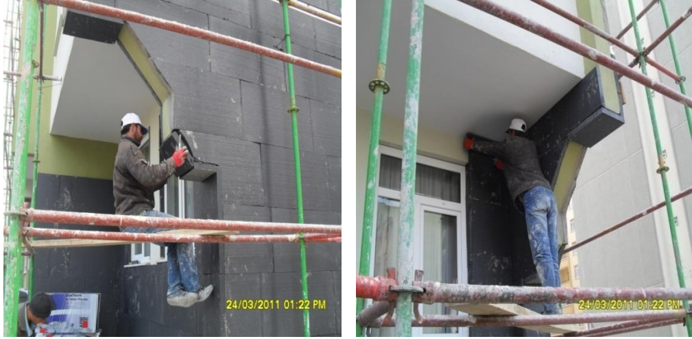
Şekil 4.2. EPS' nin uygulama şekli
