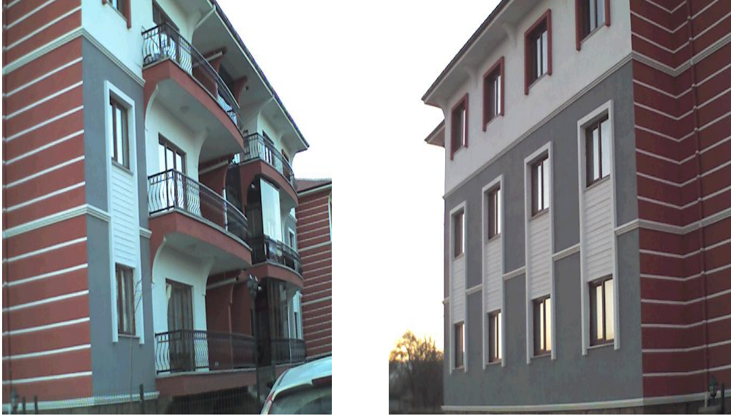
Şekil 5.14. Örnek 3'ün ısı yalıtımı yapıldıktan sonraki cephe fotoğrafları
