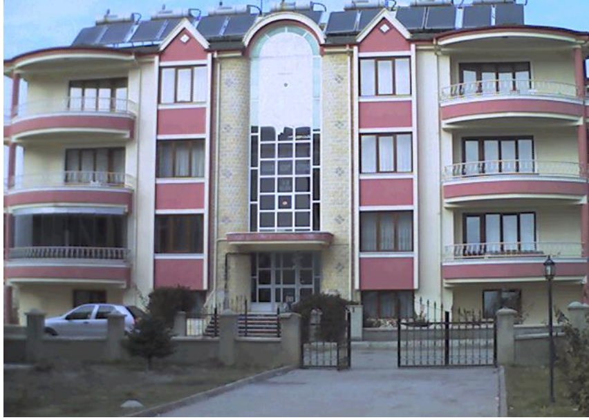
Şekil 5.18. Örnek 4’ ün yalıtım uygulandıktan sonraki görünüşü
