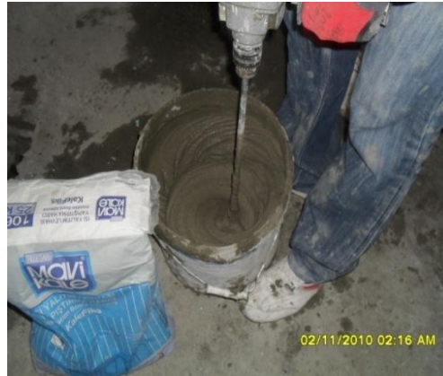
Şekil 4.13. Yalıtım harcının hazırlanması
