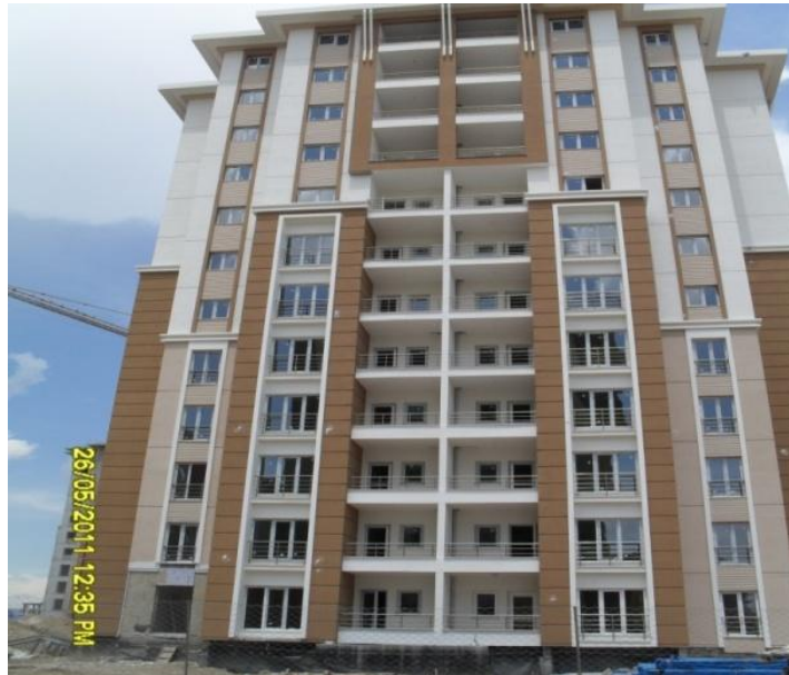
Şekil 5.37. Örnek 10'un ısı yalıtımı yapıldıktan sonra cephesi
