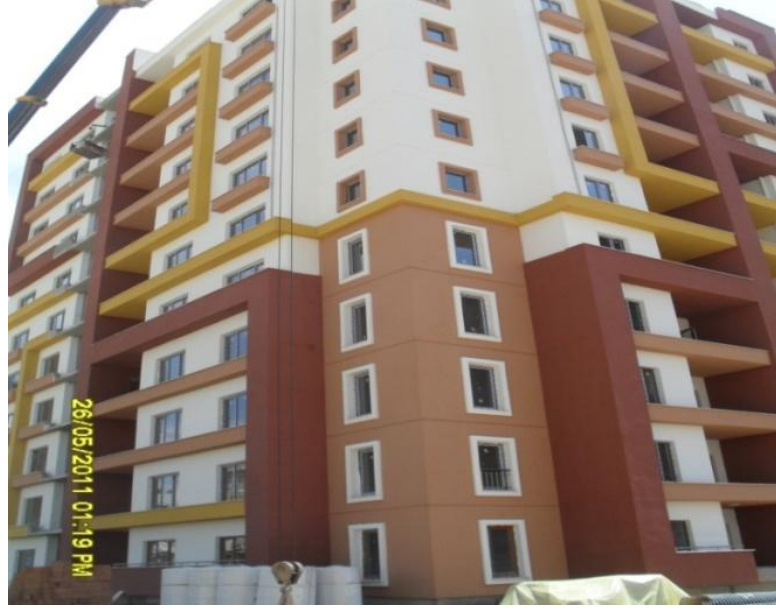
Şekil 5.35. Örnek 9'un yalıtım ve cephe kaplamasından sonraki durumu
