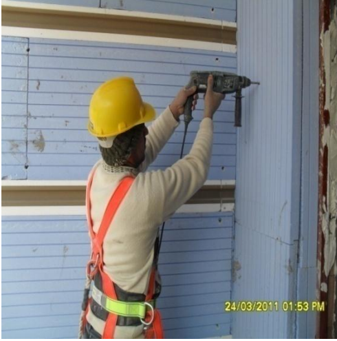
Şekil 4.16. Duvar ve ısı yalıtım levhası matkap ile delinmektedir
