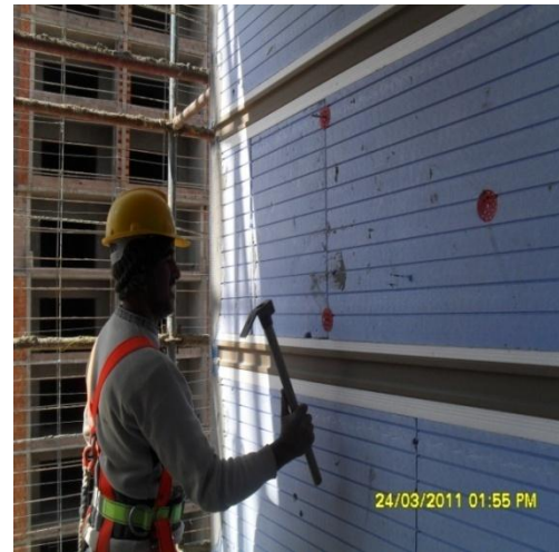
Şekil 4.17. Dübelleme işlemi yapılmaktadır
