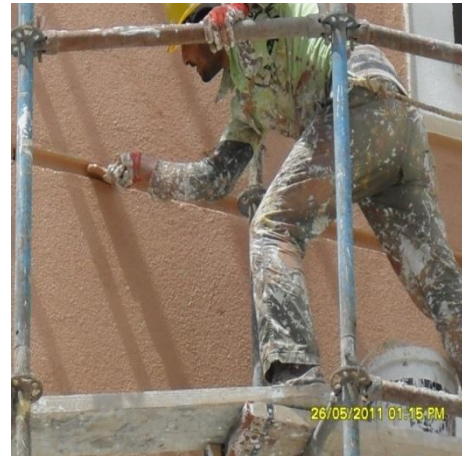
Şekil 4.9. Son kat dekoratif kaplama uygulaması
