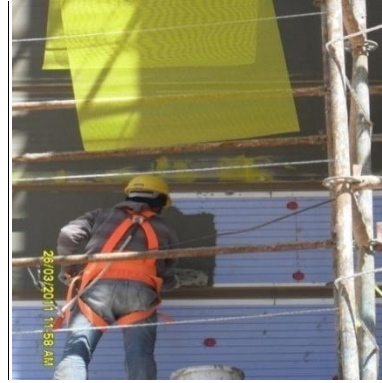
Şekil 4.20. Isı yalıtım levhasının yüzeyine ilk kat sıva uygulaması
