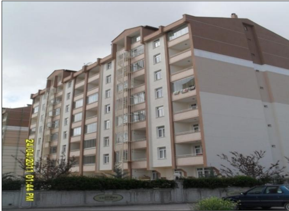
Şekil 5.34. Örnek 8'in ısı yalıtımı yapıldıktan sonraki görünüşü
