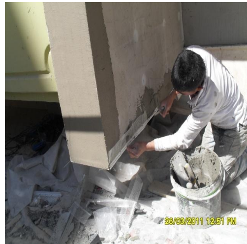
Şekil 4.18. Köşe profillerinin uygulanması
