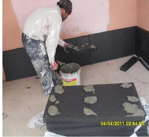
Şekil 3.14. Yapıştırıcı harcın yalıtım levhasına noktasal olarak uygulanması
