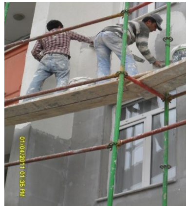
Şekil 4.23. İkinci kat yalıtım sıvası uygulanması
