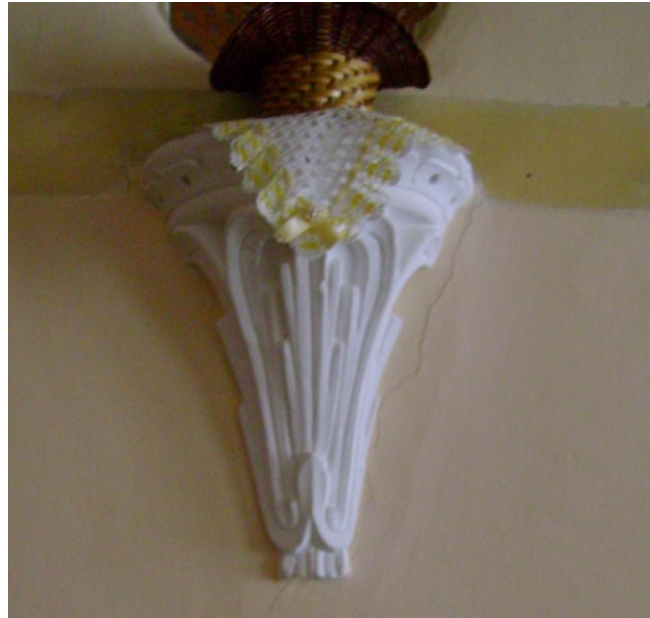
Fotoğraf: 16 Bey Sokağı Yağcıların Kızı Sadiye Hanım'ın Evi No.11-13, Birinci katın güneybatı köşesindeki odada bulunan alçı mumluk
