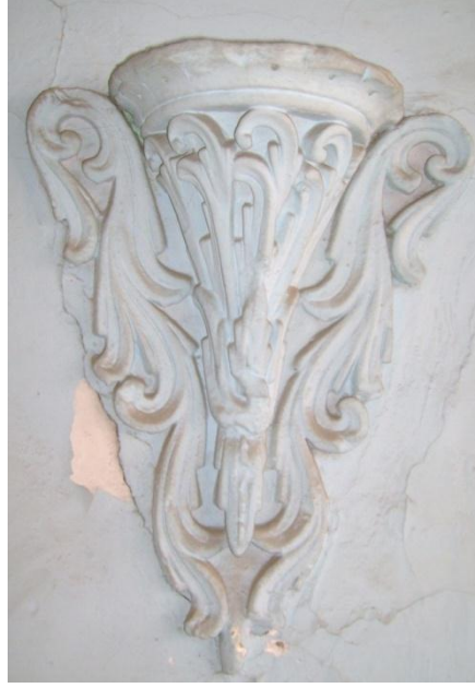
Fotoğraf: 43 Bey Sokağı Osman Paşa Konağı No.23 Birinci katın kuzeydoğu köşesindeki odada bulunan alçı mumluk
