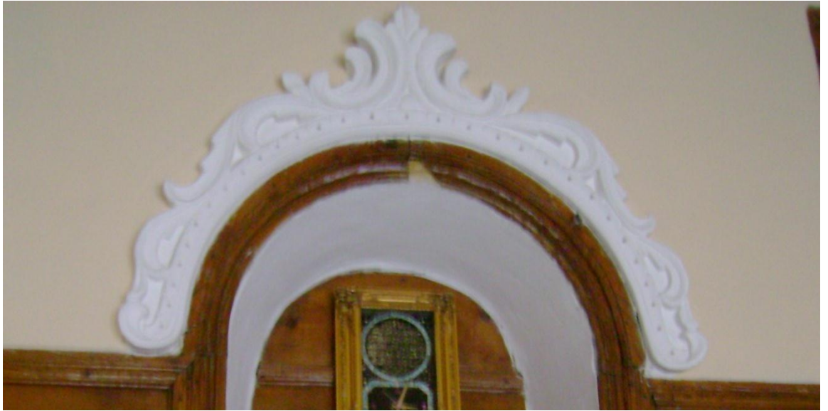
Fotoğraf: 17 Bey Sokağı Yağcıların Kızı Sadiye Hanım'ın Evi No.11-13, Birinci katın güneybatı köşesinde yer alan odada bulunan alçı niş
