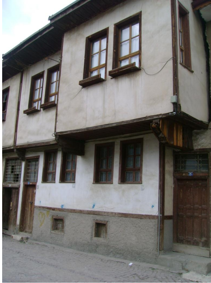
Fotoğraf: 10 Bey Sokağı No.5, Güneydoğudan görünüş
