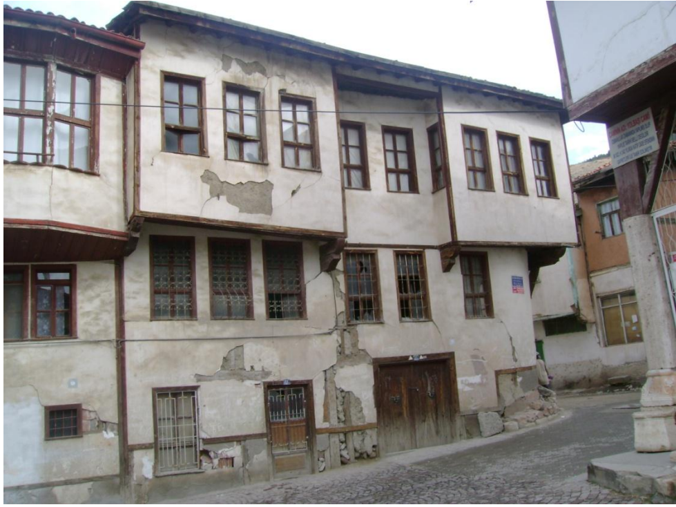
Fotoğraf: 98 Bey Sokağı No.47-47A, Güneybatıdan görünüşü
