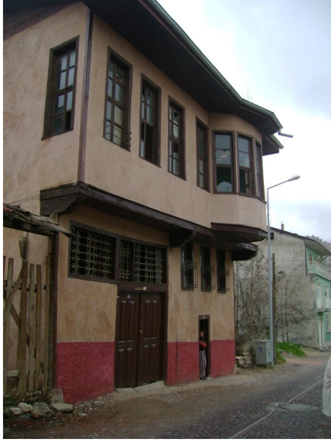
Fotoğraf: 23 Bey Sokağı Subay Hacı Ali Bey'in Evi No.14, Kuzeydoğudan görünüş
