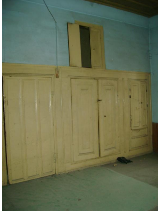
Fotoğraf: 31 Bey Sokağı Osman Paşa Konağı No.23, Zemin katın kuzeybatı köşesindeki odada bulunan ahşap dolap
