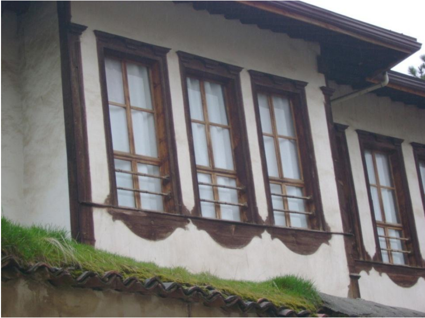
Fotoğraf: 57Bey Sokağı Yağcızade Sadullah Bey Konağı No.28-30, Kuzey cephede yer alan pencerelerden detay
