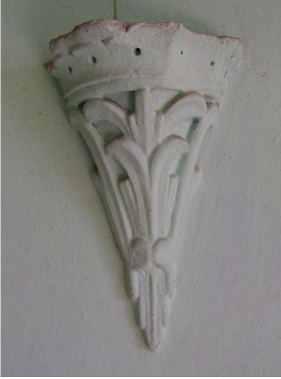
Fotoğraf: 73 Bey Sokağı No.36, Birinci katın kuzeydoğu köşesindeki odada bulunan alçı mumluk
