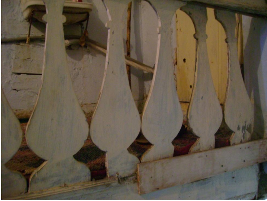
Fotoğraf: 22 Bey Sokağı Vali Konağı No.12,Birinci katın merdiven korkulukları
