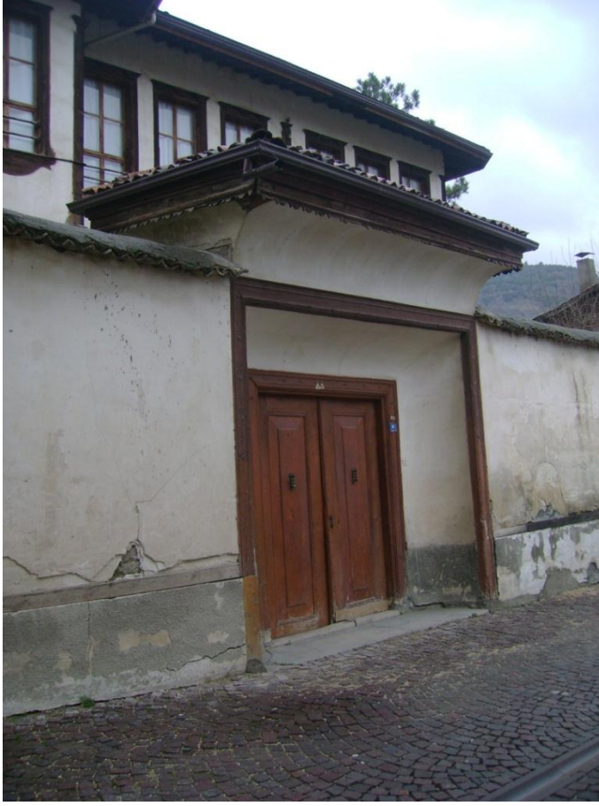
Fotoğraf: 56 Bey Sokağı Yağcızade Sadullah Bey Konağı No.28-30, Bahçe kapısı
