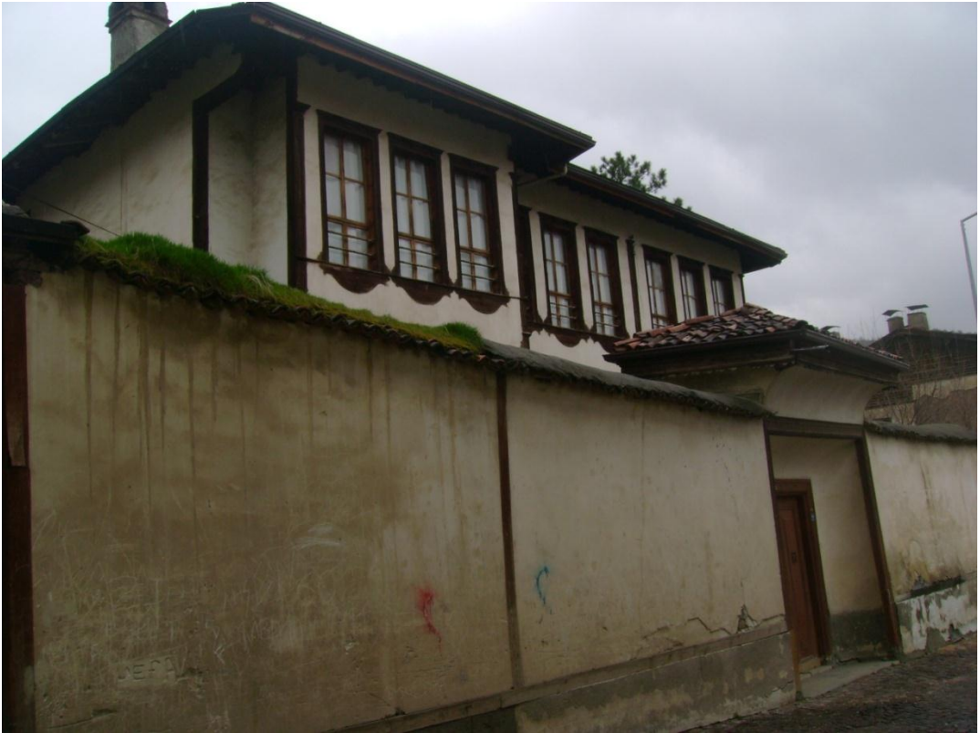
Fotoğraf: 55 Bey Sokağı Yağcızade Sadullah Bey Konağı No.28- 30,Kuzeydoğudan görünüşü
