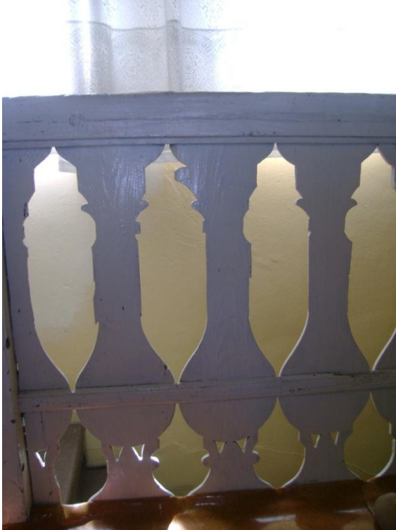
Fotoğraf: 89 Bey Sokağı Sivaslı İcracı Bekir Efendi Evi No.41-41A, Birinci kat sofada yer alan merdiven korkuluğu
