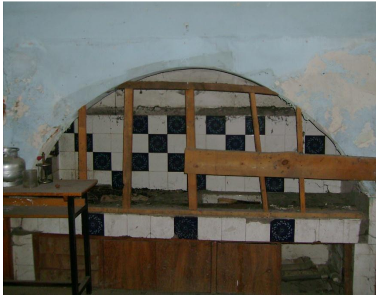
Fotoğraf: 30 Bey Sokağı Osman Paşa Konağı No.23, Zemin katın kuzeybatı köşesindeki odada bulunan ocak
