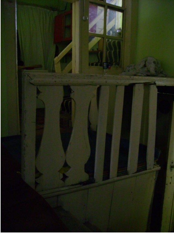
Fotoğraf: 54Bey Sokağı No.27, Zemin katın sofasındaki merdivenin korkuluğu
