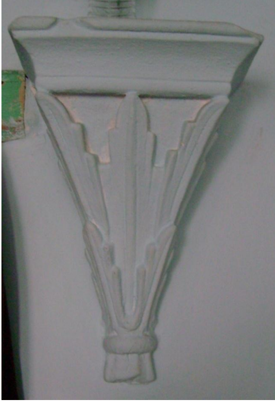
Fotoğraf: 60 Bey Sokağı Yağcızade Sadullah Bey Konağı No.28-30, Birinci katın sofasında bulunan alçı mumluk
