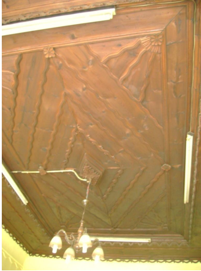
Fotoğraf: 33 Bey Sokağı Osman Paşa Konağı No.23, Zemin katın güneydoğu odanın tavanı
