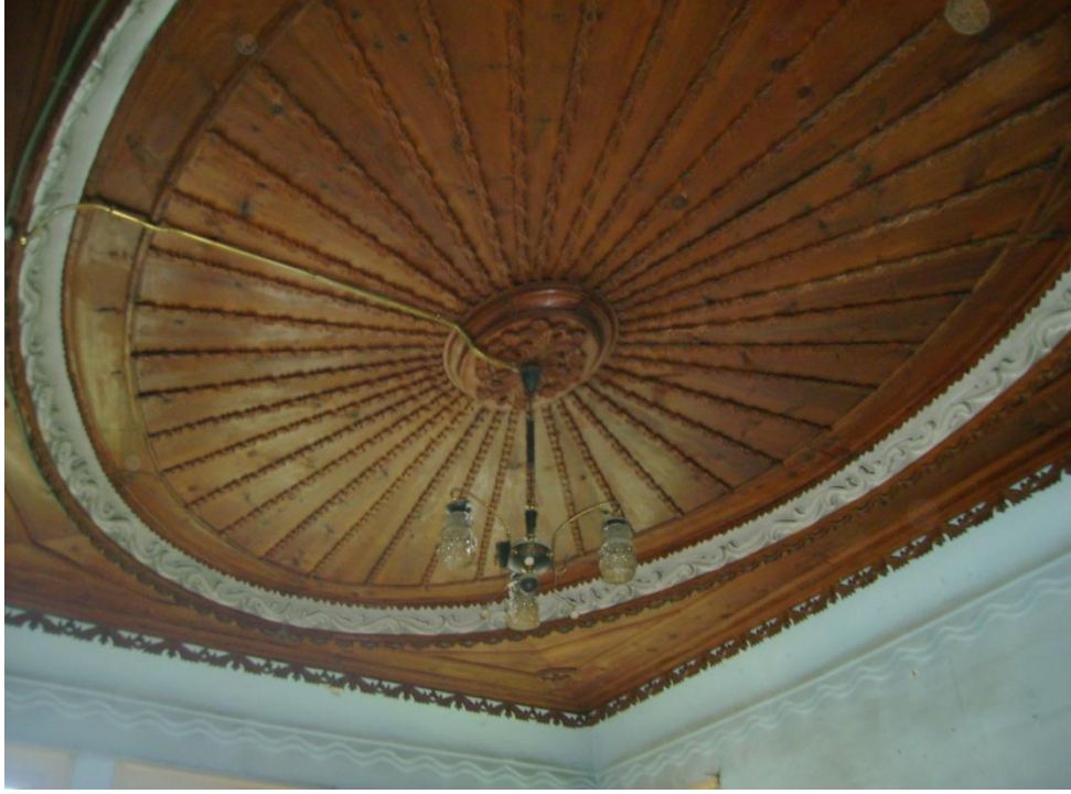
Fotoğraf: 39 Bey Sokağı Osman Paşa Konağı No.23, Birinci katın kuzeydoğu köşesindeki odanın tavanı
