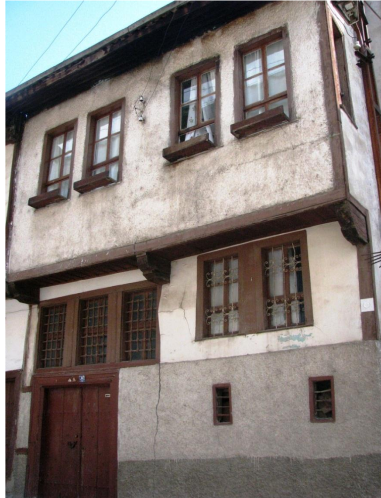
Fotoğraf: 68 Bey Sokağı No.36, Kuzeybatıdan görünüşü
