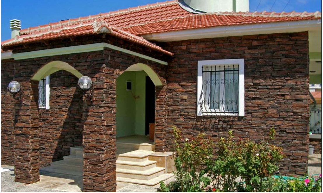
Şekil 2.12. Dış cephede birim ağırlığı düşük suni dekoratif kaplama taş kullanımı
