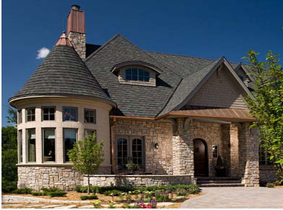
Şekil 2.13. Dış cephede birim ağırlığı düşük suni dekoratif kaplama taş kullanımı
