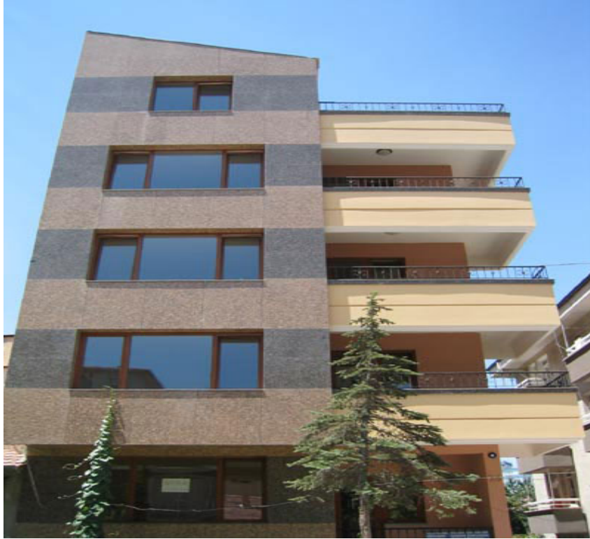
 ekil 2.1. Dı  Cephe Kaplamasında Granit Kullanımı
