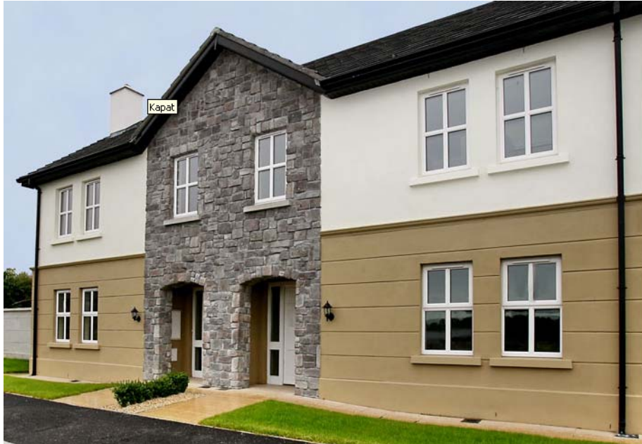
Şekil 2.14. Dış cephe kaplamasında birim ağırlığı düşük suni dekoratif kaplama taşı birim ağırlığı düşük dekoratif kaplama plakasının beraber kullanılması
