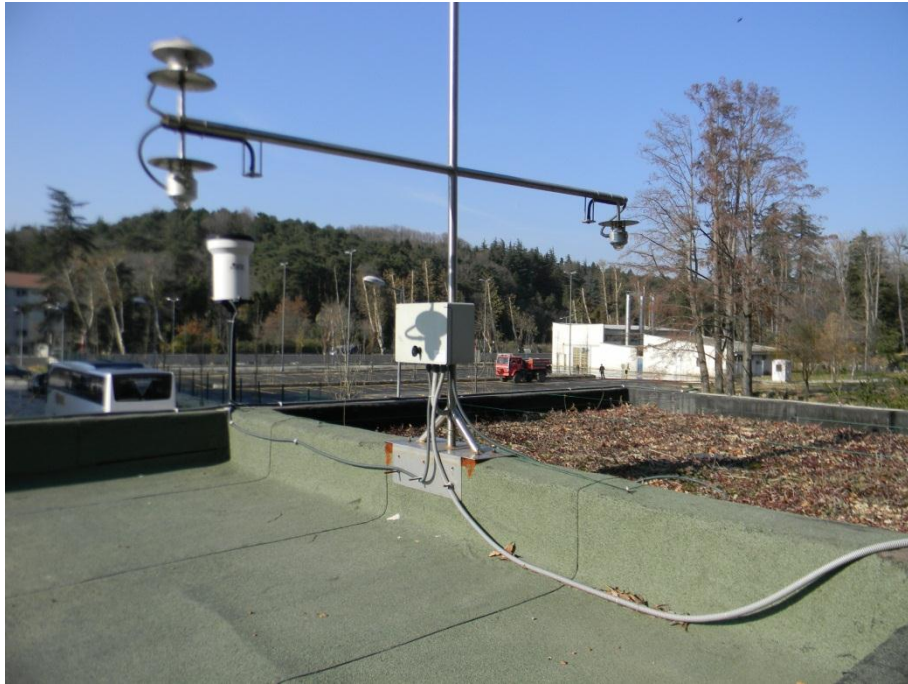
Ek-7.2.2 - Çatı yüzeyinde bulunan piranometreler ve kızılötesi termometreler
