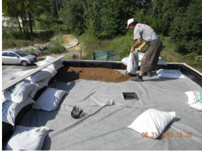
Şekil 3.6: Yeşil çatı sisteminin oluşturulması
