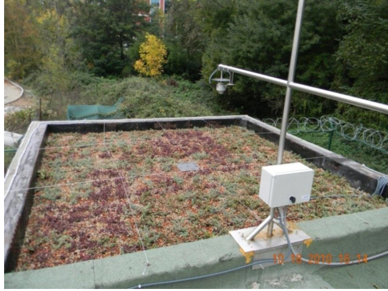
Ek-7.3.1 - Yeşil çatı görünümü - 18 Ekim 2010
