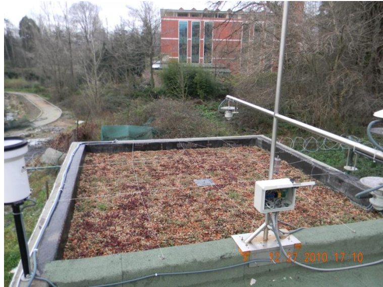
Ek-7.3.2 - Yeşil çatı görünümü - 27 Aralık 2010
