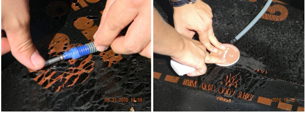
Şekil 3.7: Yeşil çatı katmanları arasında bulunan sıcaklık sensörleri(solda) ve ısı akısı ölçüm plakaları(sağda)
