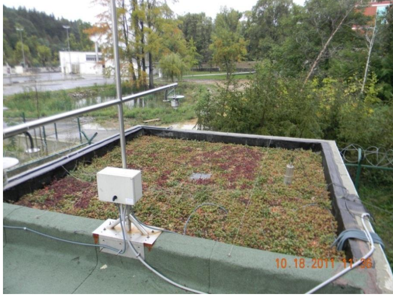
Ek-7.3.5 - Yeşil çatı görünümü - 18 Ekim 2011
