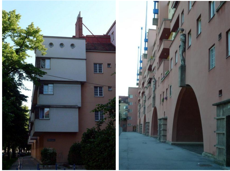
Şekil 4.33 Karl Marx Hof yerleşmesi görüşleri [98]
