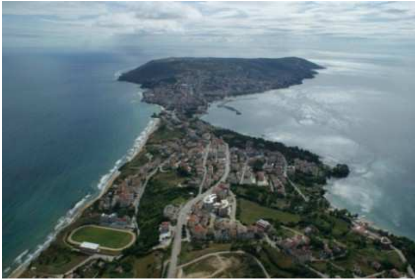
Resim 2.1: Sinop Kenti Havadan Görünüm 2010
