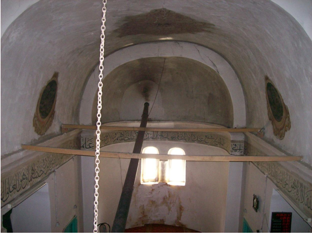
Res. 117: İbrala Kilisesi iç Mekan Apsise Bakış
