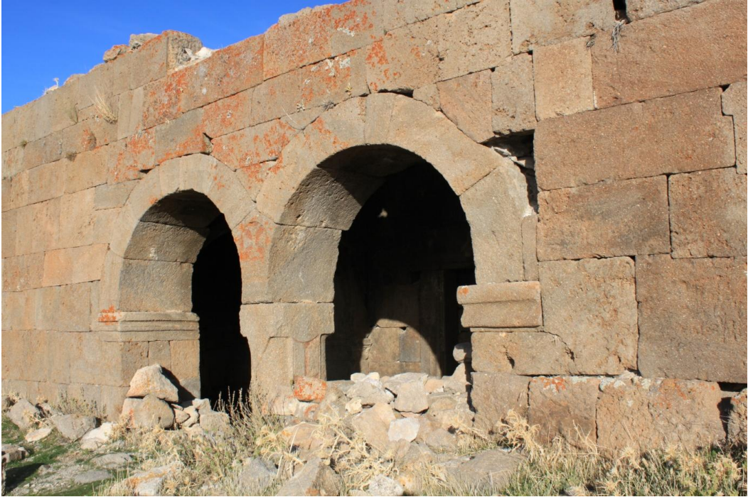
Res. 39: Değle 31 Nolu Bazilikanın Giriş Cephesi
