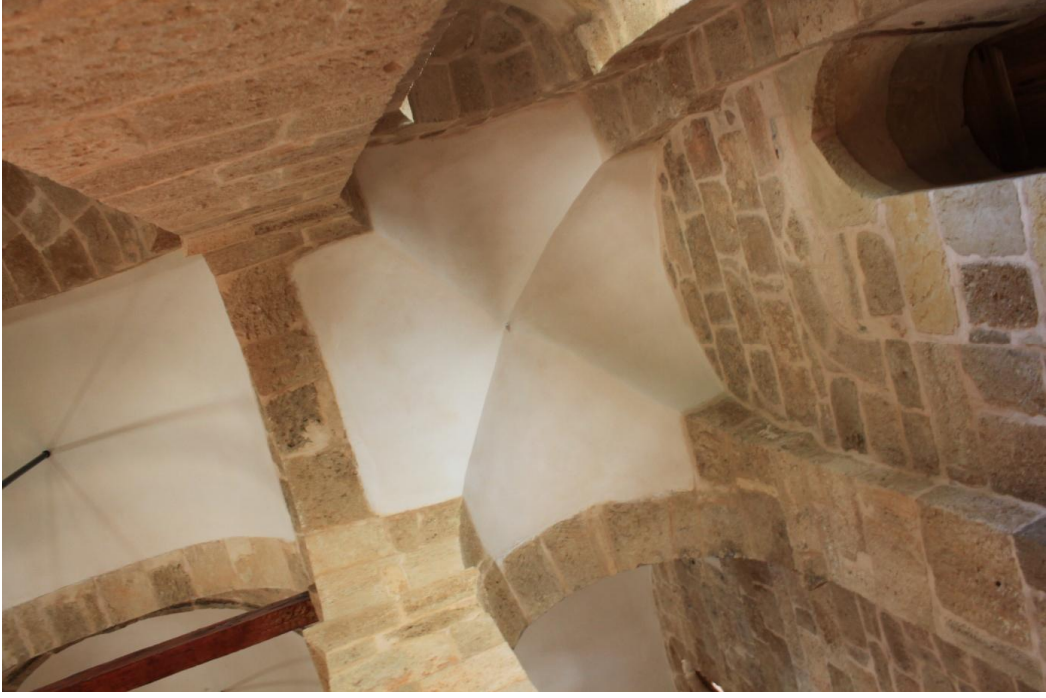
Res. 107: Fisandon Kilisesi İç Mekân Örtü Sistemi
