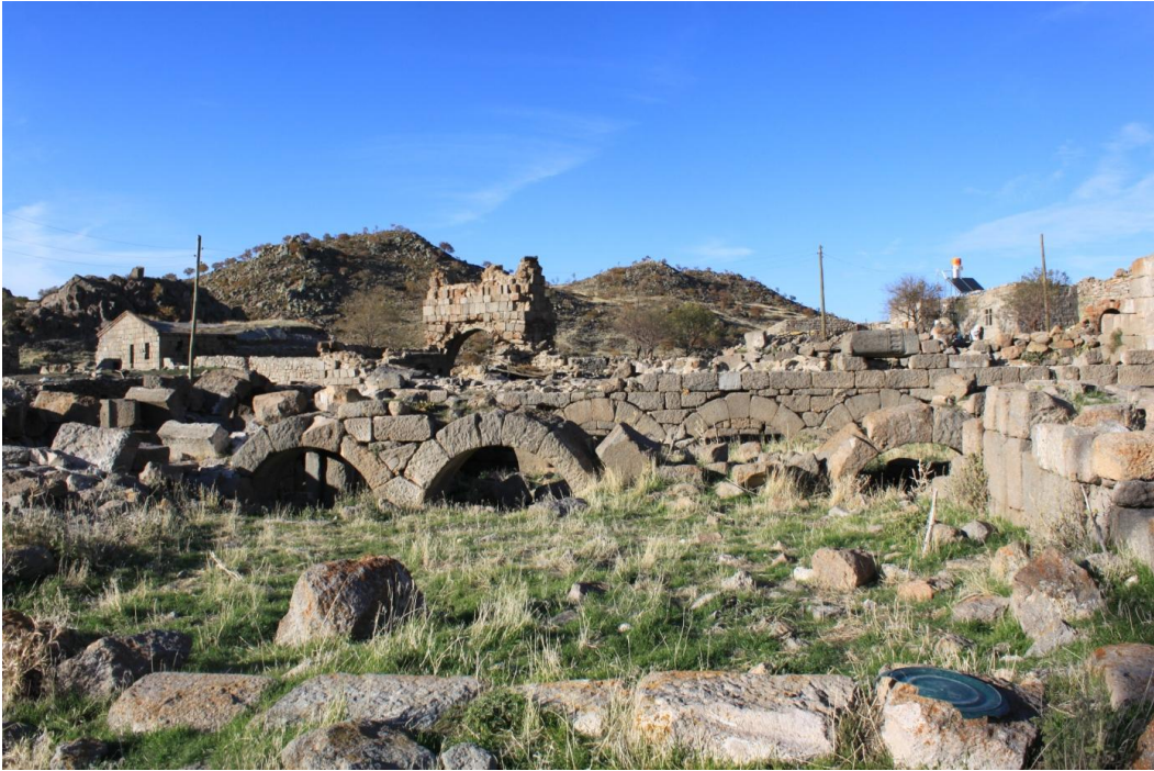
Res. 51: Değle 32 Nolu Bazilikanın Yan Nef Kemerlerinin Bugünkü Durumu
