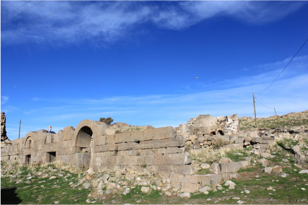
Res. 47: Değle 32 Nolu Bazilikanın Giriş Cephesi
