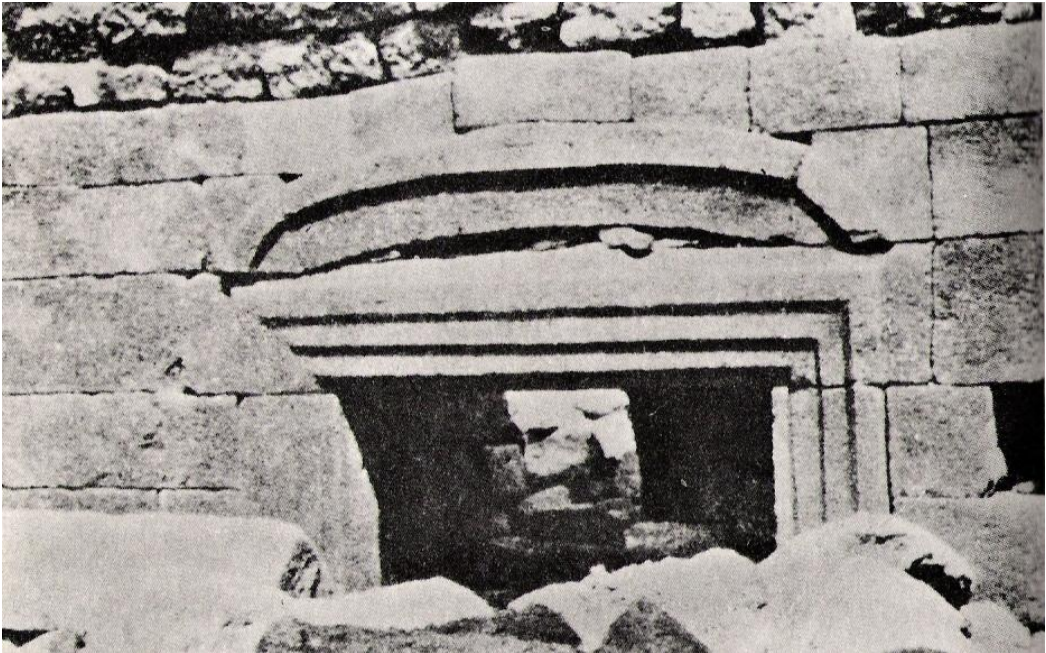
Res. 33: Madenşehir 3 Nolu Bazilikanın Kapısı Üzerindeki Tahfif Kemer (Ramsay'den)
