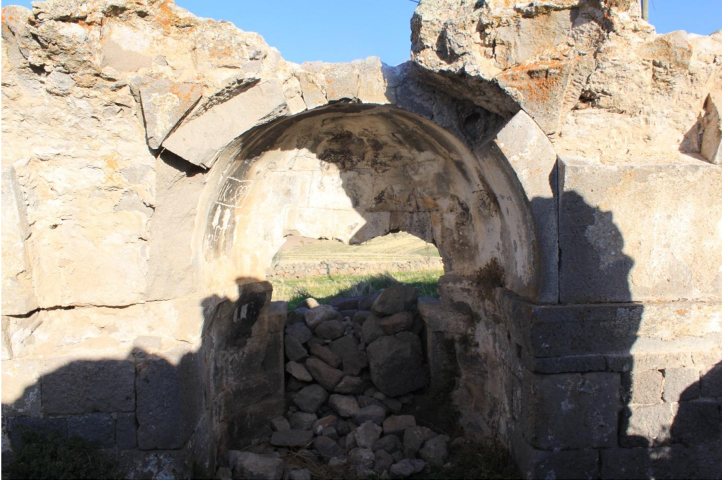
Res. 24: Madenşehir 12-21-22 Nolu Yapılardan 12 Nolu Yapının Apsis Görünümü
