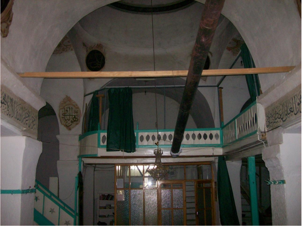
Res. 112: İbrala Kilisesi İç Mekan
