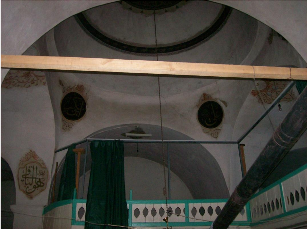
Res. 120: İbrala Kilisesi iç Mekan Geçişler
