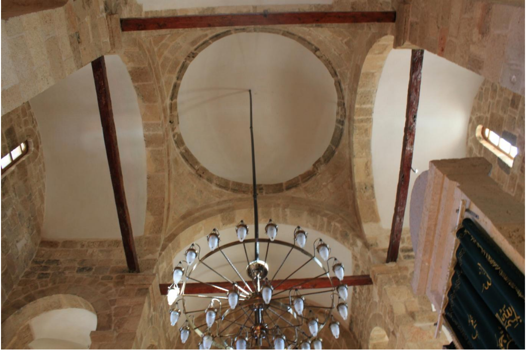
Res. 106: Fisandon Kilisesi İç Mekân Örtü Sistemi
