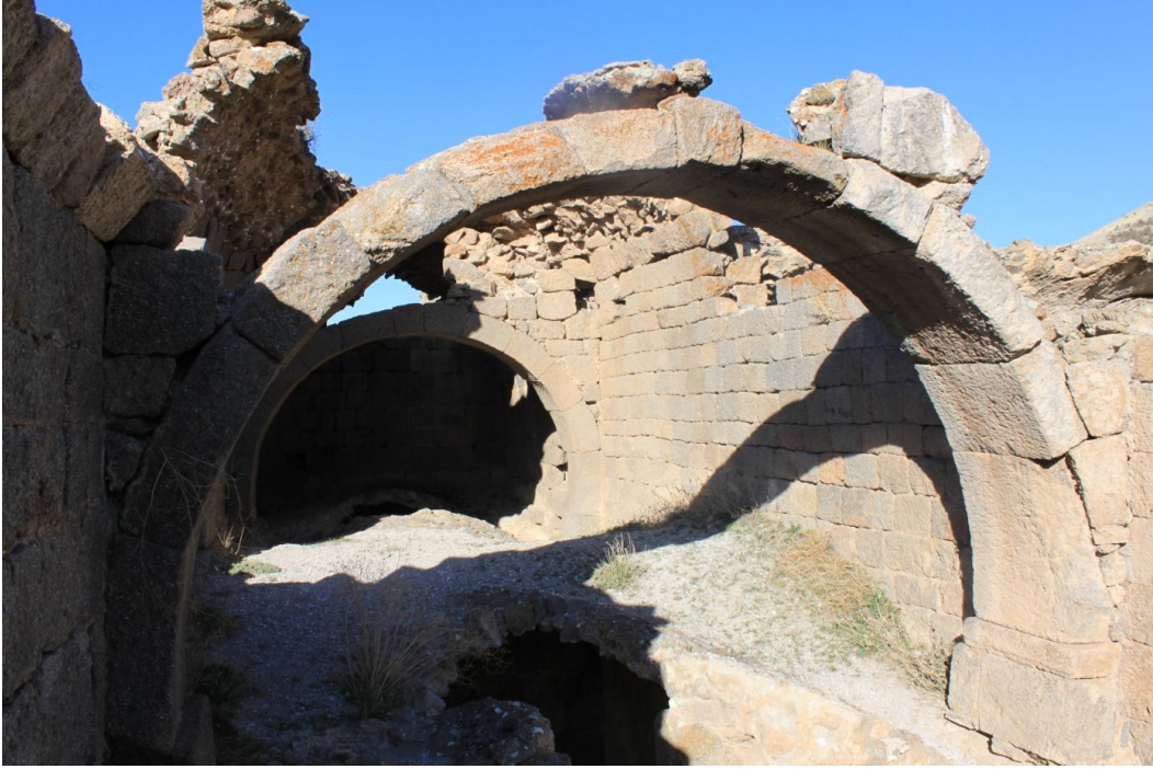
Res. 8: Madenşehir 1 Nolu Bazilika Narteks Kısmı Galeri Katı
