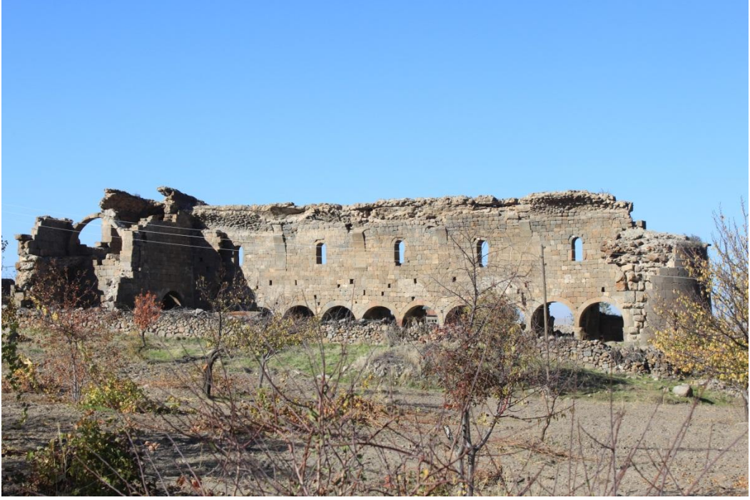
Res. 4: Madeneşhir 1 Nolu Bazilika Güneyden Genel Görünüm
