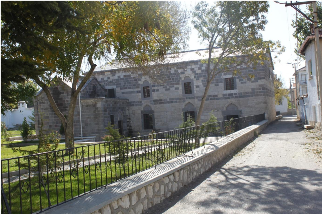
Res. 65: Çeşmeli Kilise Kuzeyden Genel Görünüm
