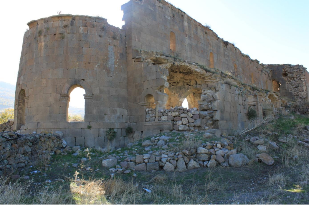
Res. 12: Madenşehir 1 Nolu Bazilika Kuzey Dođudan Apsis Kısımı ve Galeri Katı
