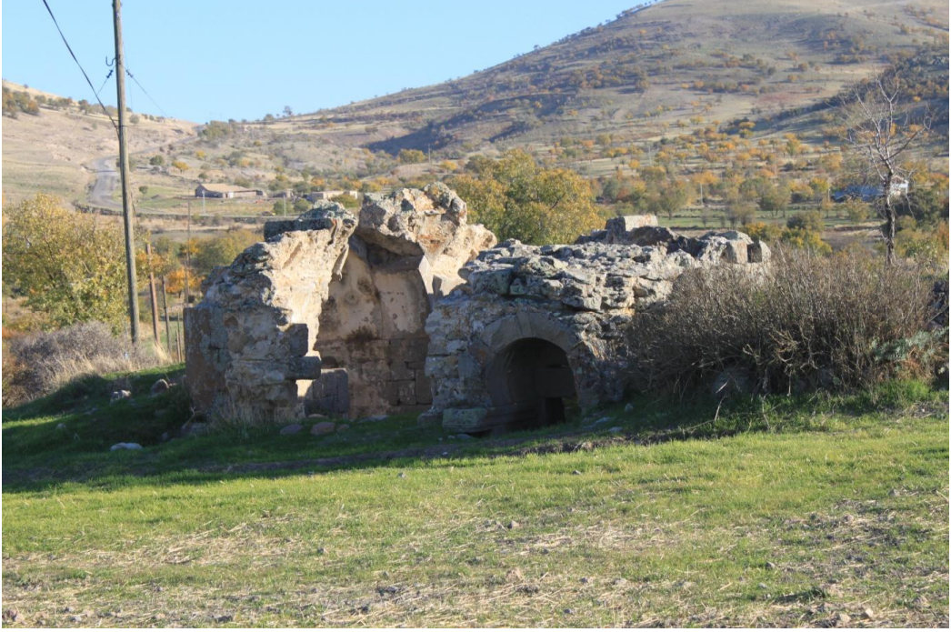
Res. 22: Madenşehir 12-21-22 Nolu Yapılardan 12 Nolu Yapının Genel Görünümü
