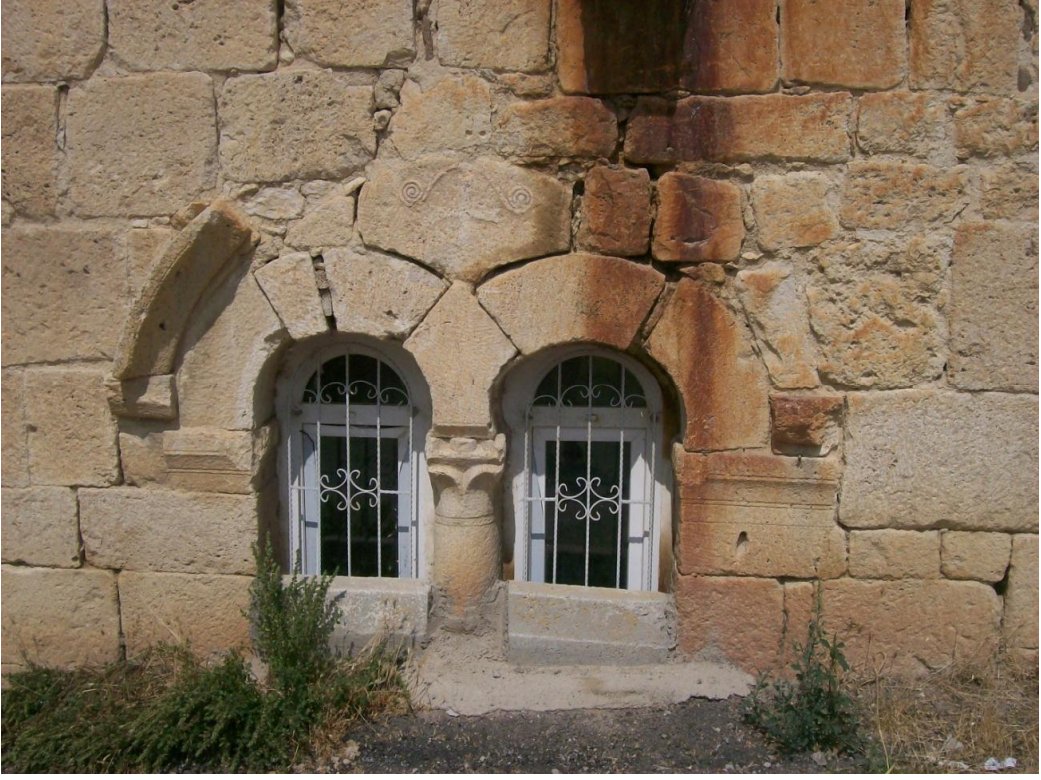
Res. 111: İbrala Kilisesi Apsis Dıştan Görünüm
