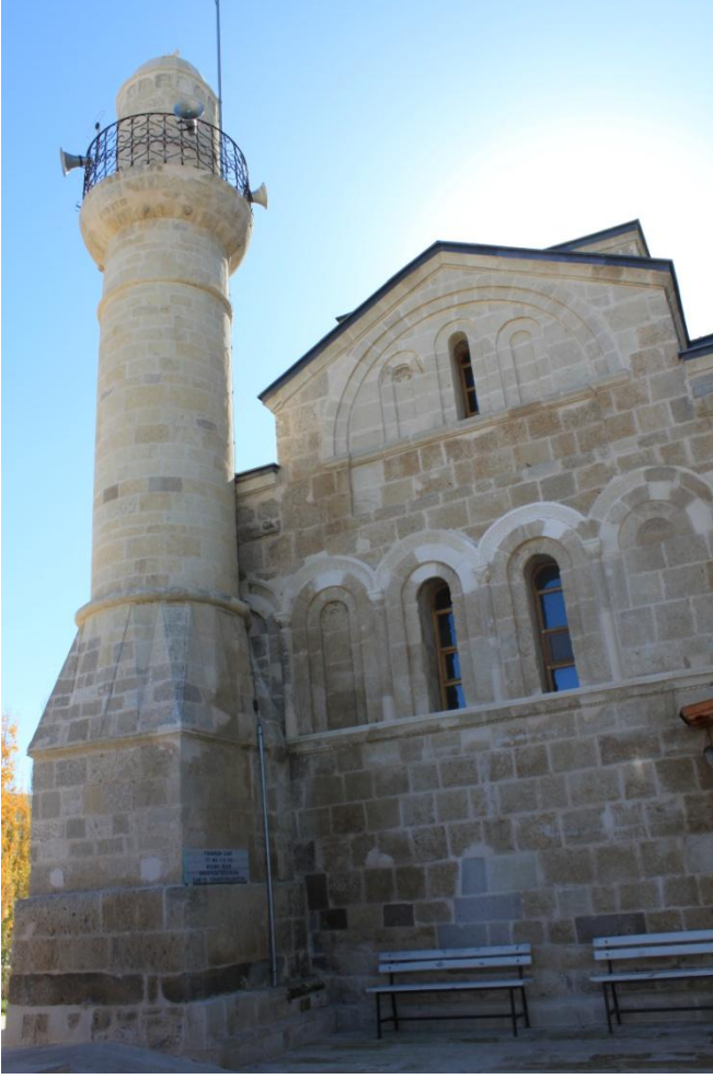
Res. 95: Fisandon Kilisesi Kuzey Cephe Görünümü
