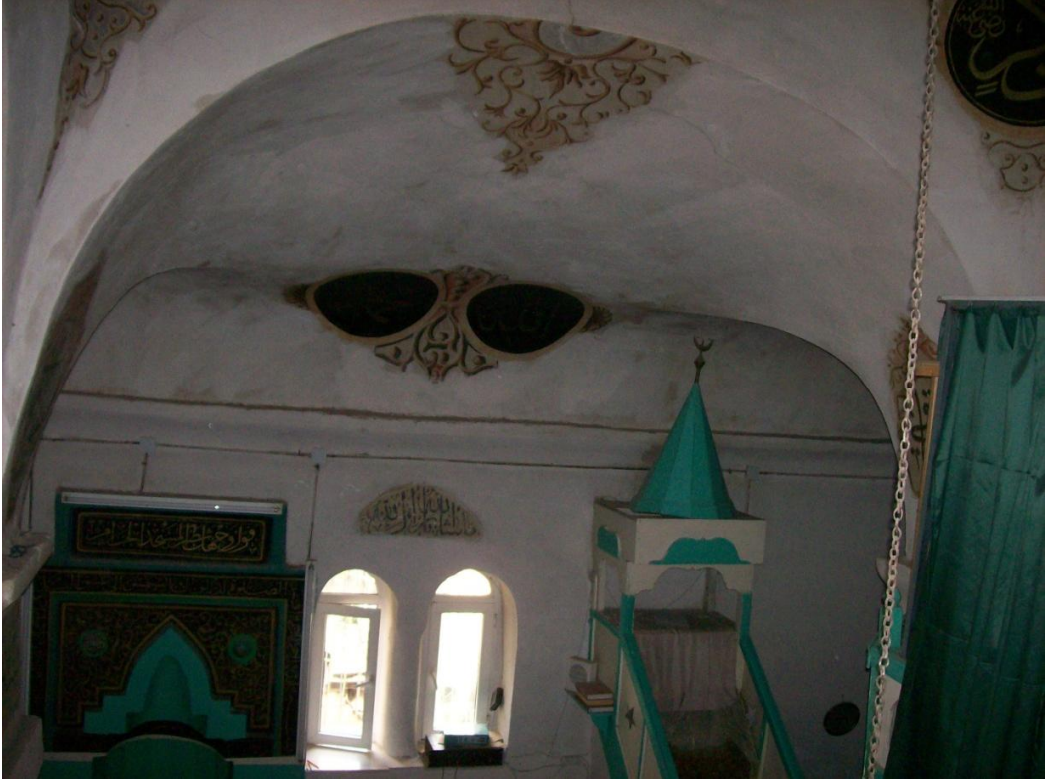
Res. 119: İbrala Kilisesi iç Mekan Geçişler
