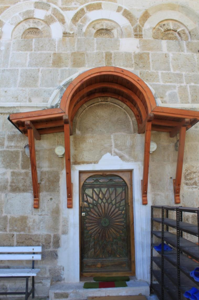
Res. 96: Fisandon Kilisesi Kuzey Cephe Kapı Girişi
