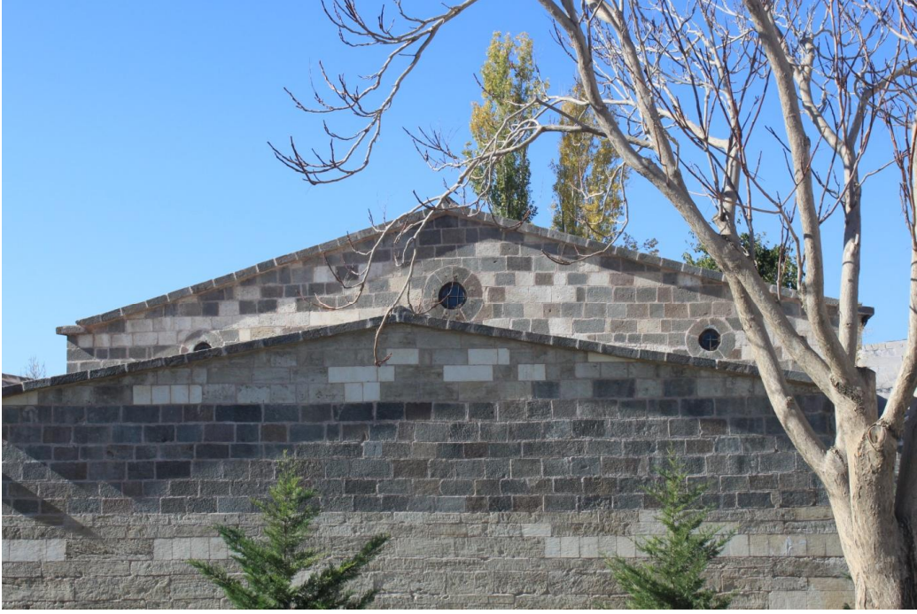
Res. 70: Çeşmeli Kilise Doğu Cephe ve Örtü Sistemi
