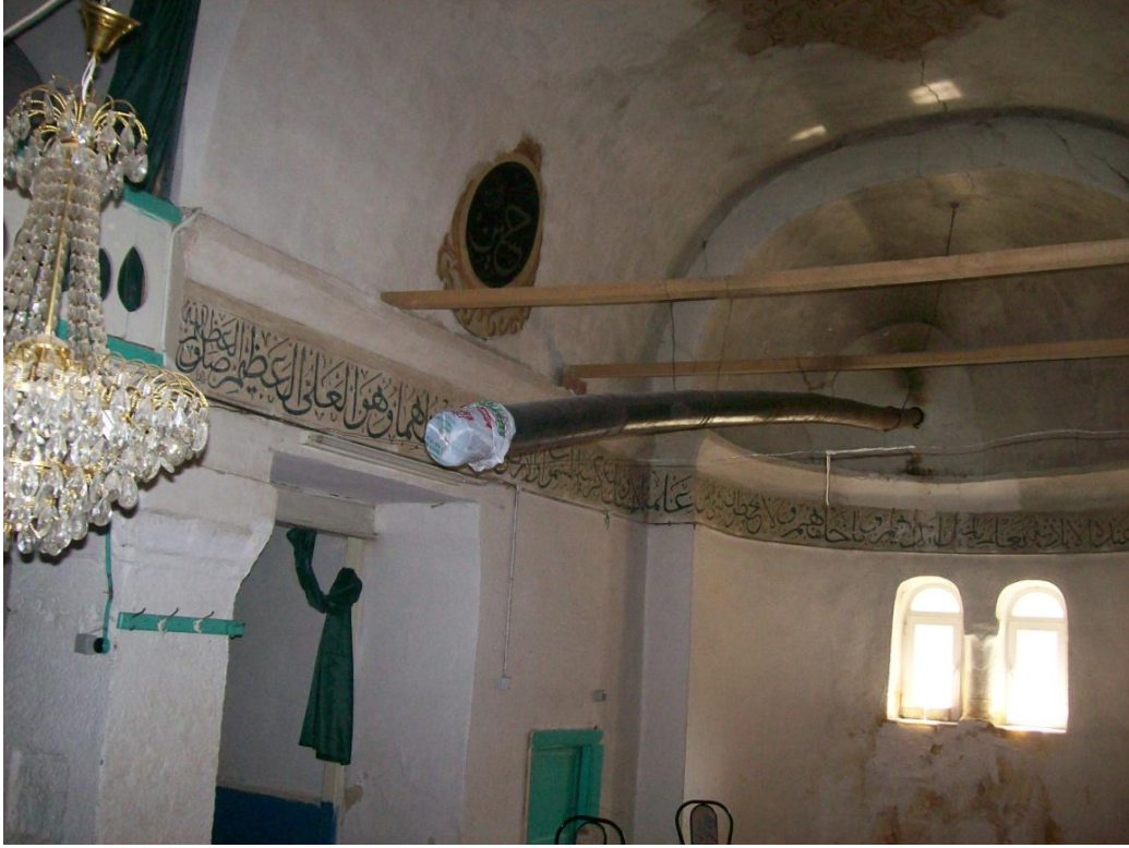
Res. 113: İbrala Kilisesi iç Mekan Geçişler
