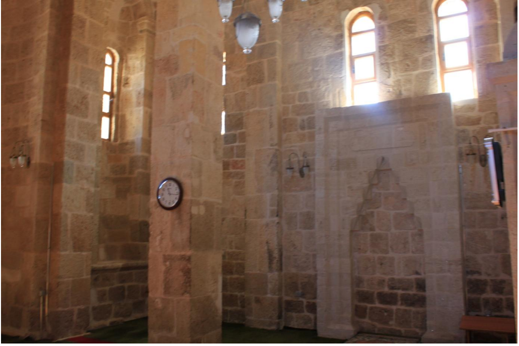
Res. 103: Fisandon Kilisesi Kuzey Duvar İç Mekân
