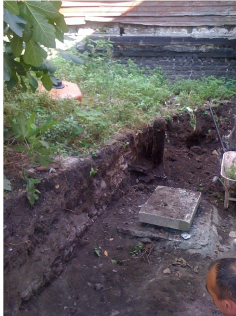
Şekil 4.21 İplerin izdüşümleri doğrultusunda yapılan kazı çalışmaları ve kuyunun çevresinin açılması, 2010 (Kudeb).
