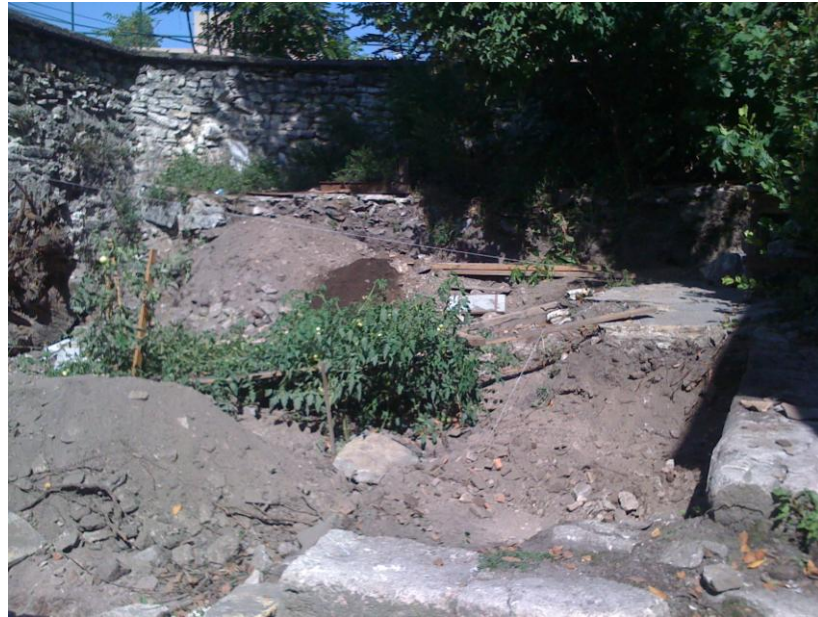
Şekil 4.23 Ön bahçenin iz belirleyici ipler doğrultusunda kazılarak duvar izlerinin ortaya çıkarılması, 2010 (Kudeb).
