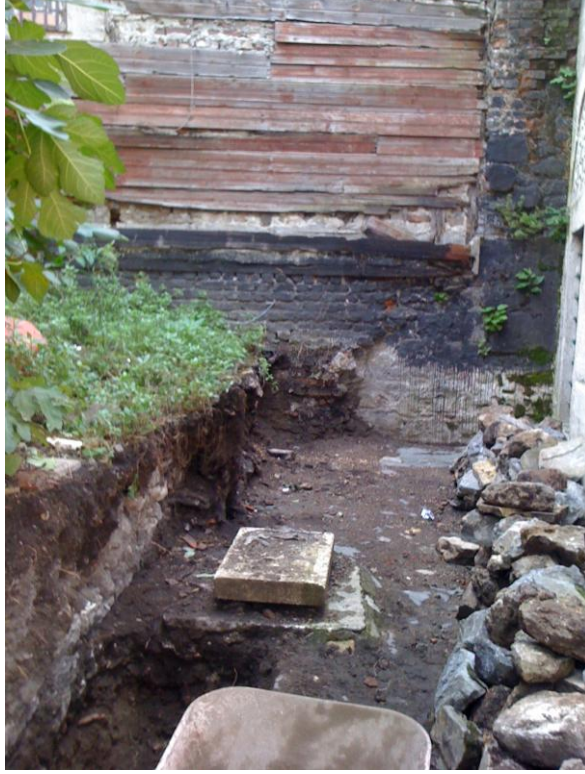
Şekil 4.22 Moloz taş duvarın yıkılarak pervititch dönemine ait duvar izinin ortaya çıkarılması, 2010 (Kudeb).
