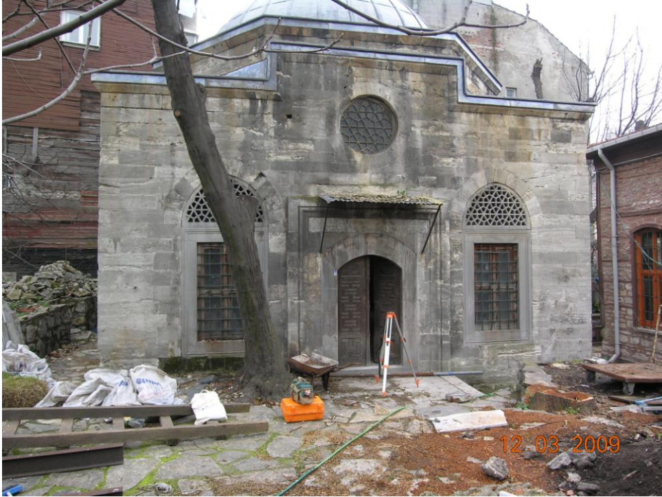
Şekil 4.5 Yapının giriş cephesi, 2009 (Kudeb).
