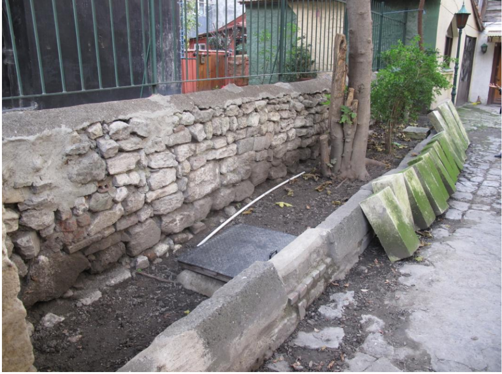
Şekil 4.52 Hüsrev paşa sokağı yönündeki moloş taş duvar (Kudeb).
