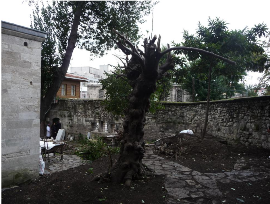
Şekil 4.27 Üst bahçede yapılan üst örtü temizliği, 2010 (Kudeb).
