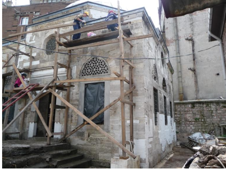
Şekil 4.10 Cephe temizliği yapılırken giriş cephesinin görünümü, 2009 (Kudeb).
