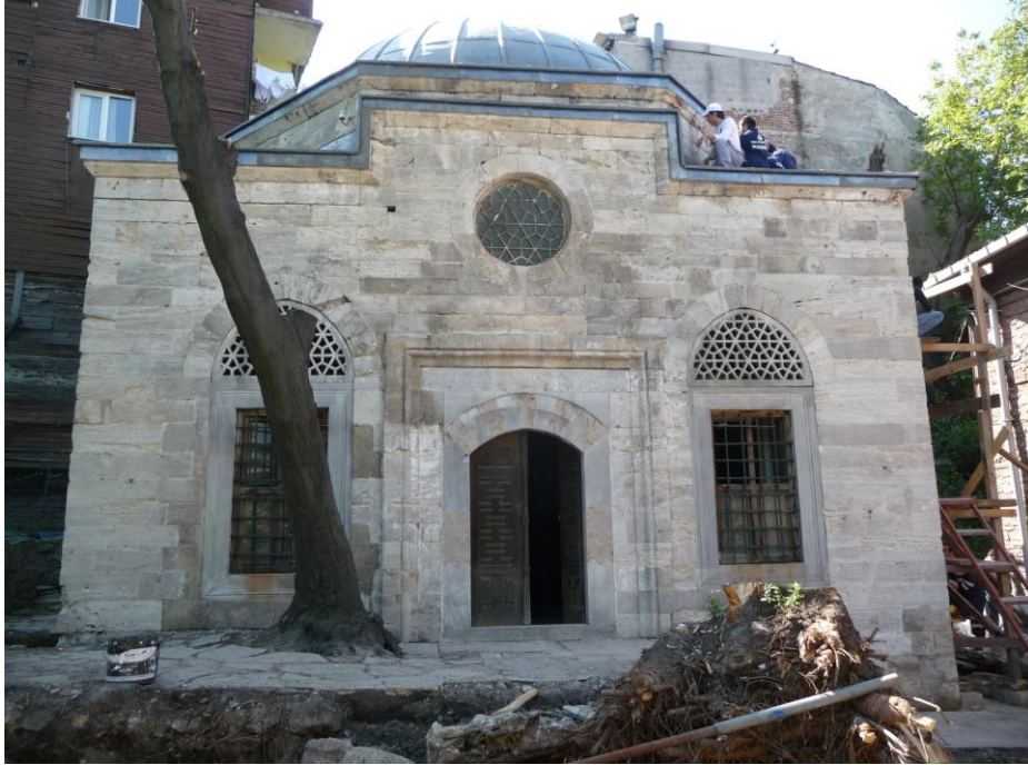
Şekil 4.13 Cephe temizliği tamamlandıktan sonraki görünüm, 2009 (Kudeb).
