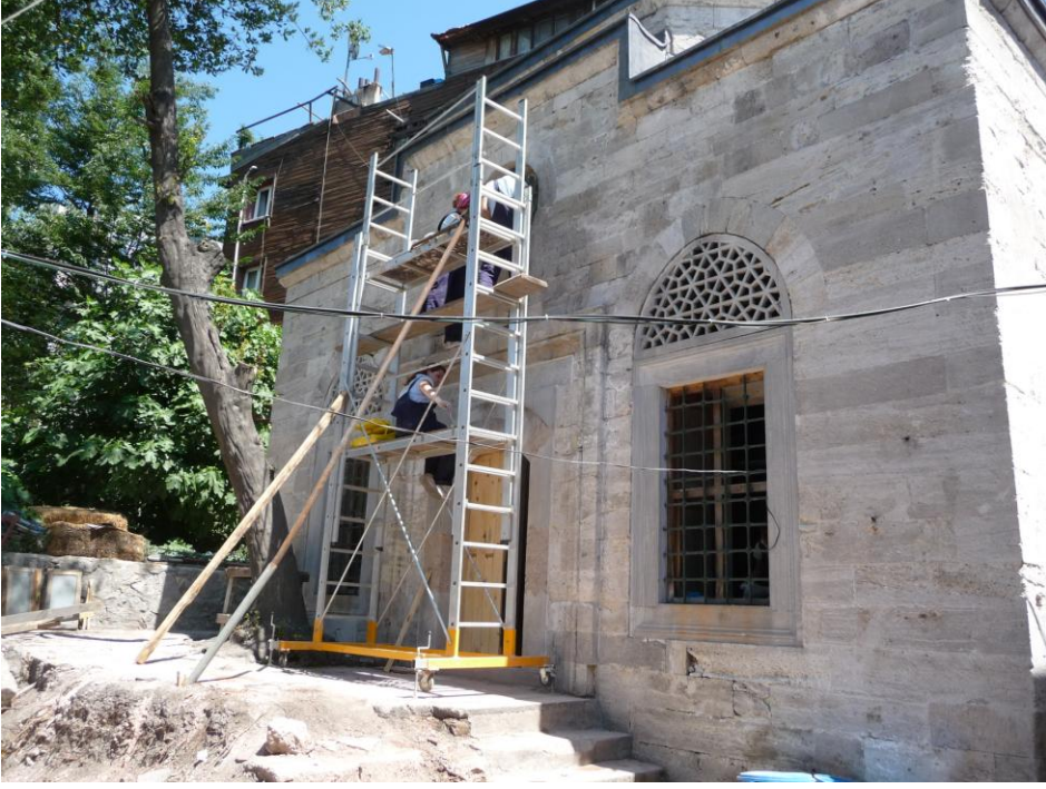
Şekil 4.12 Kitabe'nin onarım çalışmaları, 2009 (Kudeb).
