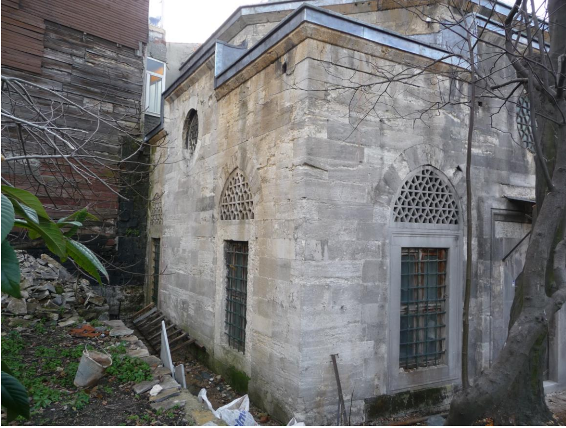
Şekil 4.6 Komşu parseldeki yapının dar’ul kurranın kuzeydoğu cephesine bitişik olan konumu (Kudeb).
