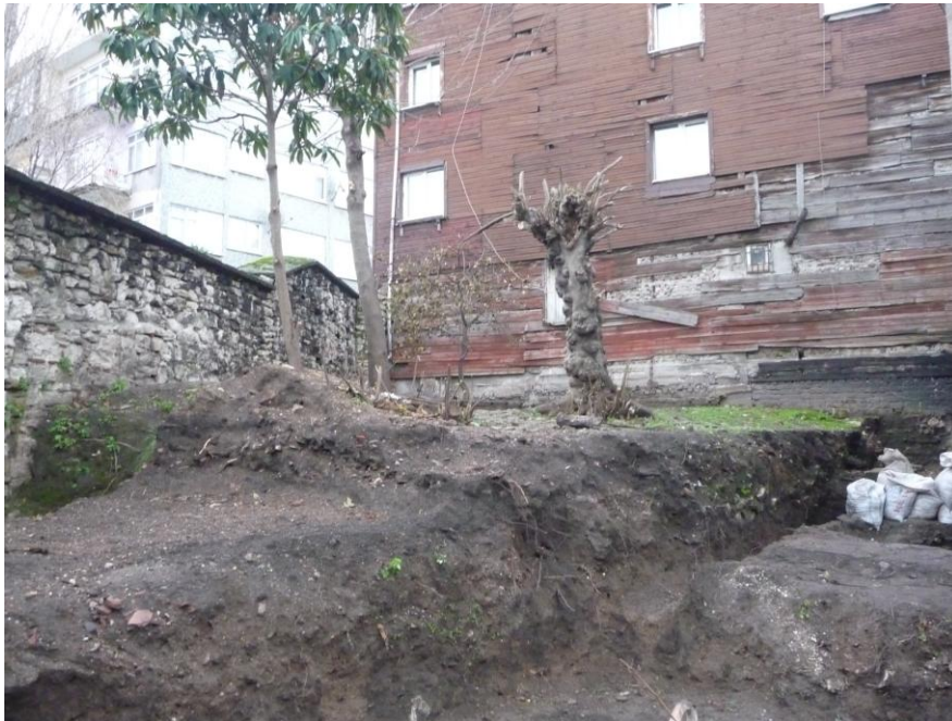
Şekil 4.37 Duvar izlerinin ortaya çıkarılması ve kot düşürme çalışmaları, 2010 (Kudeb).
