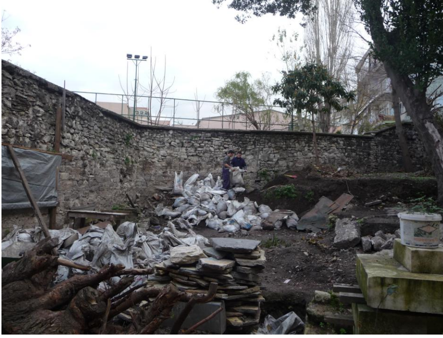
Şekil 4.32 Üst bahçenin kot seviyesinin düşürülmesi çalışmaları, 2010 (Kudeb).
