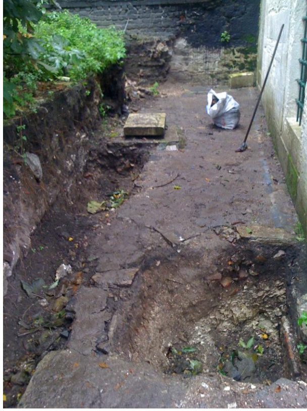
Şekil 4.24 Yapının köşe noktasının bir metre derinliğinde kazılarak temel seviyesinin belirlenmesi, 2010 (Kudeb).
