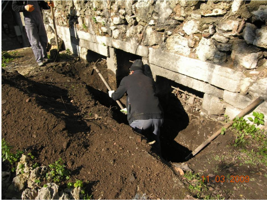
Şekil 4.15 Orjinal kot belirleme için yapılan kazı çalışmaları, 2009 (Kudeb).
