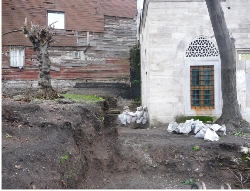
Şekil 4.36 Duvar izlerinin ortaya çıkarılması ve kot düşürme çalışmaları, 2010 (Kudeb).
