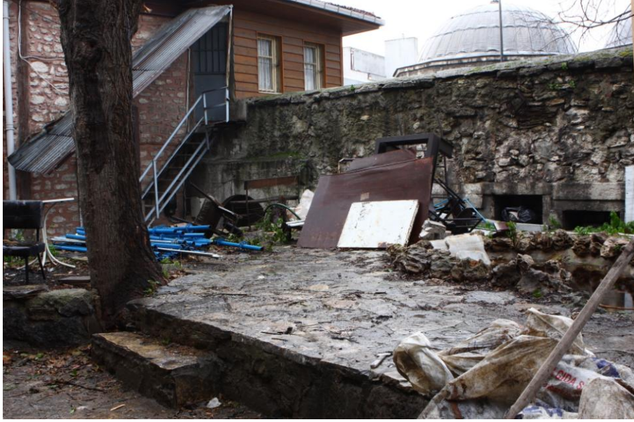
Şekil 4.14 Ön bahçenin, dış bahçe duvarı pencerelerini kapatacak şekildeki yüksek kot seviyesi, 2009 (Kudeb).
