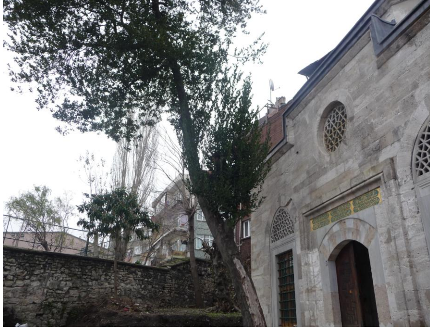
Şekil 4.34 Yapıya zarar verme tehlikesi olan defne ağacının budanması, 2010 (Kudeb).
