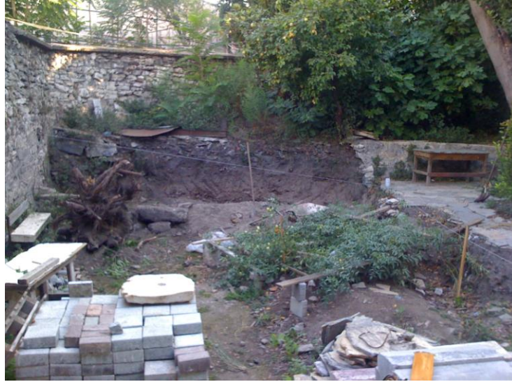
Şekil 4.18 Duvar hatlarının izdüşümlerini belirleyici iplerin alana yerleştirilmesi, 2010 (Kudeb).
