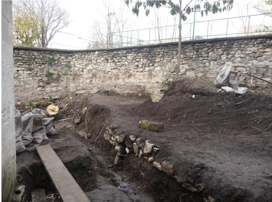
Şekil 4.43 Pervitich haritalarına göre ortaya çıkarılan moloz taş duvarın temizlenerek ortaya çıkarılması, 2011 (Kudeb).
