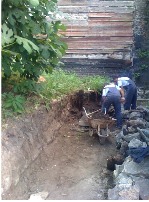
Şekil 4.20 İplerin izdüşümleri doğrultusunda yapılan kazı çalışmaları, 2010 (Kudeb).
