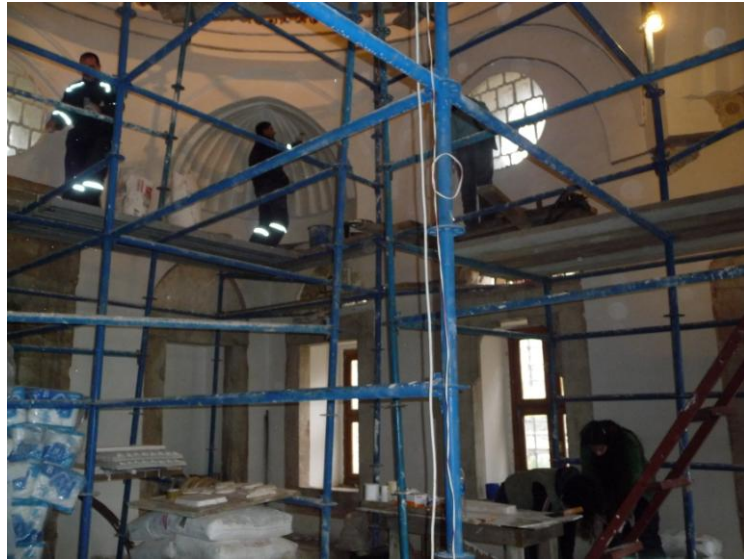
Şekil 4.11 Mukarnasların silikon kalıplarının çıkarılma çalışmaları, 2009 (Kudeb).
