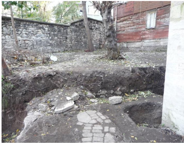
Şekil 4.29 Yapının giriş kotunda ortaya çıkarılan arnavut kaldırım ve mermer taşlardan oluşan döşeme izi, 2010 (Kudeb).
