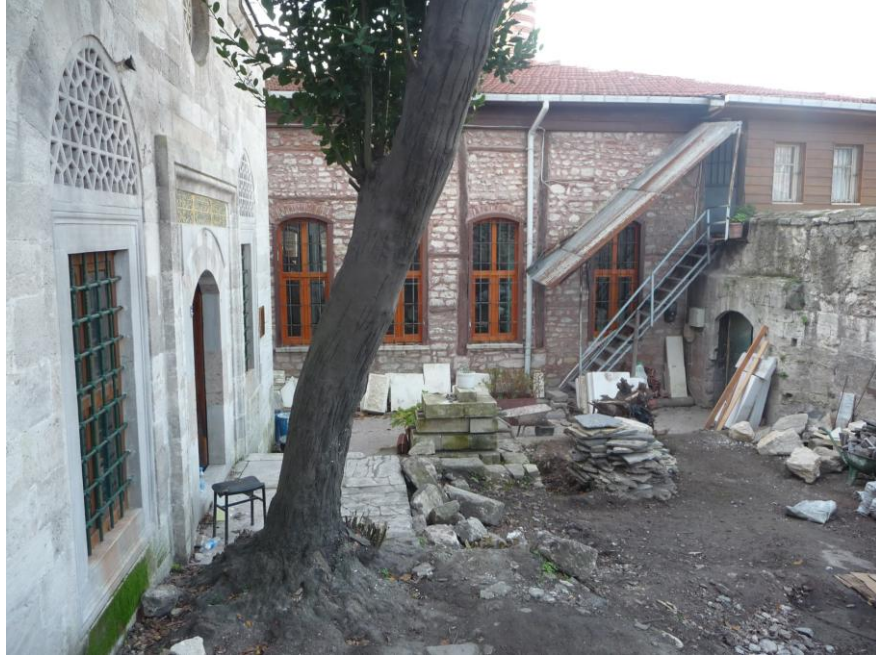
Şekil 4.30 Uygulama sahasının molozlardan temizlenerek hazırlanması, 2010 (Kudeb).
