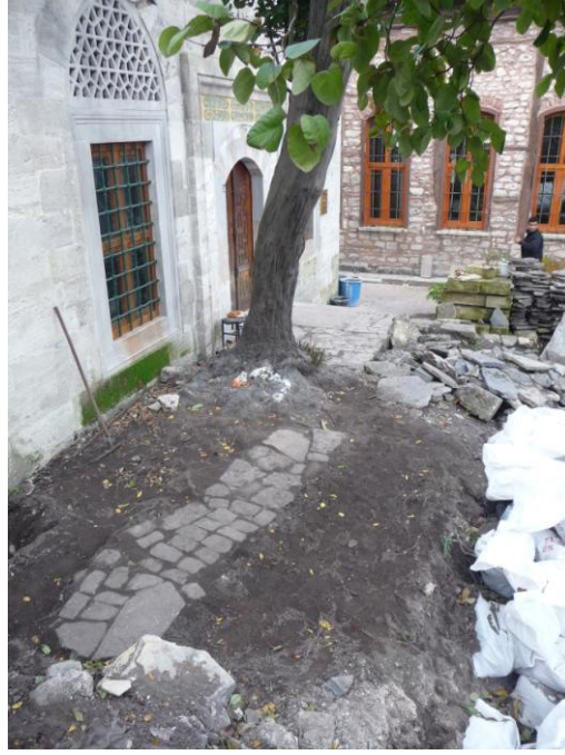
Şekil 4.28 Yapının giriş kotunda ortaya çıkarılan arnavut kaldırım ve mermer taşlardan oluşan döşeme izi, 2010 (Kudeb).
