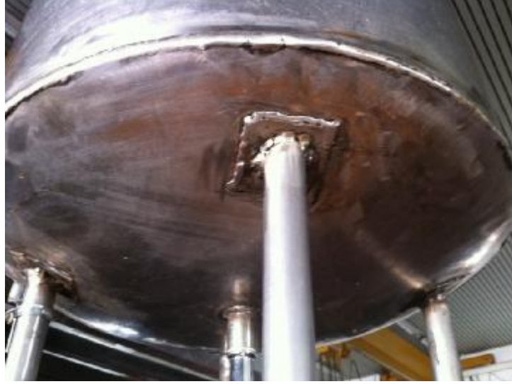
Şekil 3.18. Yastıkların depoya kaynaklanmasının görünümü
