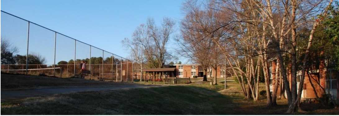
Şekil 4.11 : Pilot çalışmanın yapıldığı konut yerleşimi; “E.S.King Village Konut Yerleşimi”, NC State University, ABD (Garip, 2009).
