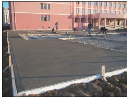
Şekil 7.30 Tören alanı zemininin şartnamede belirtilen standartları 2x2 m'lik anolar halinde iken alanda 4x4 m'lik anolar halinde dökülmüştür (Erkişi 2012).
