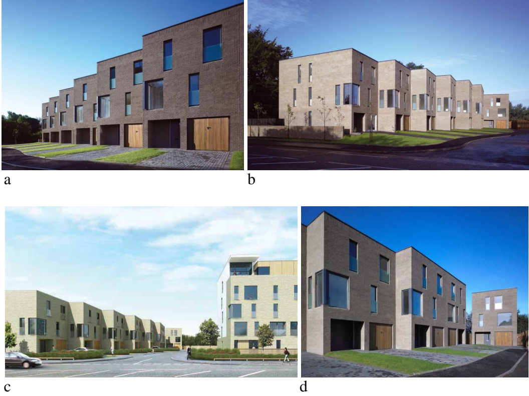
Şekil 5.3 Cumbernauld konutlarından görünüm (a,b,c,d) (URL-3, 2012).
