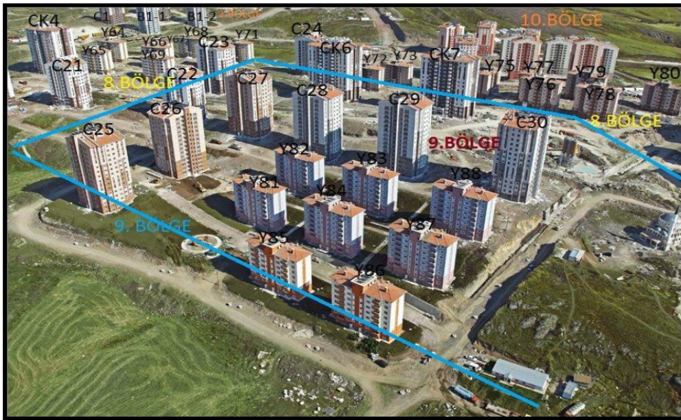
Şekil 7.7 9. Bölge toplu konut adası görünümü (Erkut 2012).
