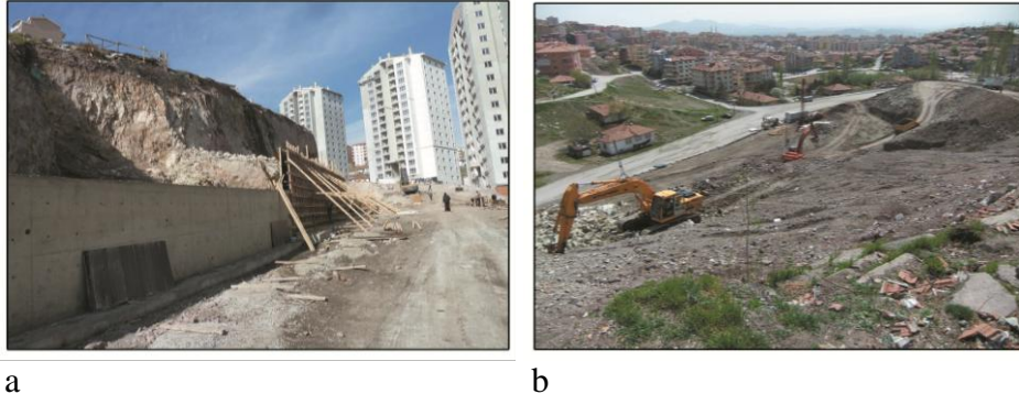
Şekil 7.60 Arazi şekillendirmesi görünümüleri a. Çalışma alanı yamaçta yer aldığından yerleşimlerin yerlerini açmak için harcanan zaman ve çıkan hafriyatın nereye döküleceği sorun oluşturmaktadır (Özkar İnş. 2010). b. Çalışma alanının kayalık ve eğimin dik olmasından dolayı kazı çalışmaları uzun zaman almaktadır (Özkar İnş. 2010).
