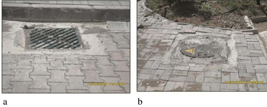
Şekil 7.13 Yağmur suyu drenajı çözümleri a. Alanda yer alan ızgaraların etrafındaki boşluğu kapatmak için yapılan beton imalatı kötü görüntü oluşturmaktadır (Erkişi 2012). b. Yaya yolu ve kaldırımlar içerisinde kalan rögar kapakları kullanıcılar için sorun oluşturmaktadır (Erkişi 2012).
