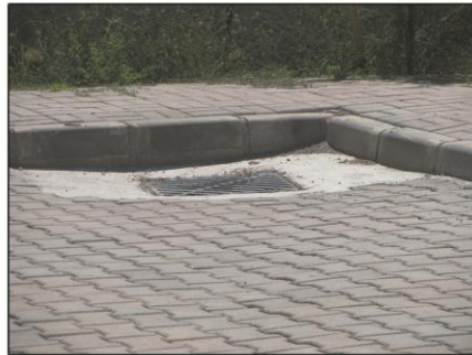
Şekil 7.25 Sert zemin uygulama hatası (Erkişi 2012).
