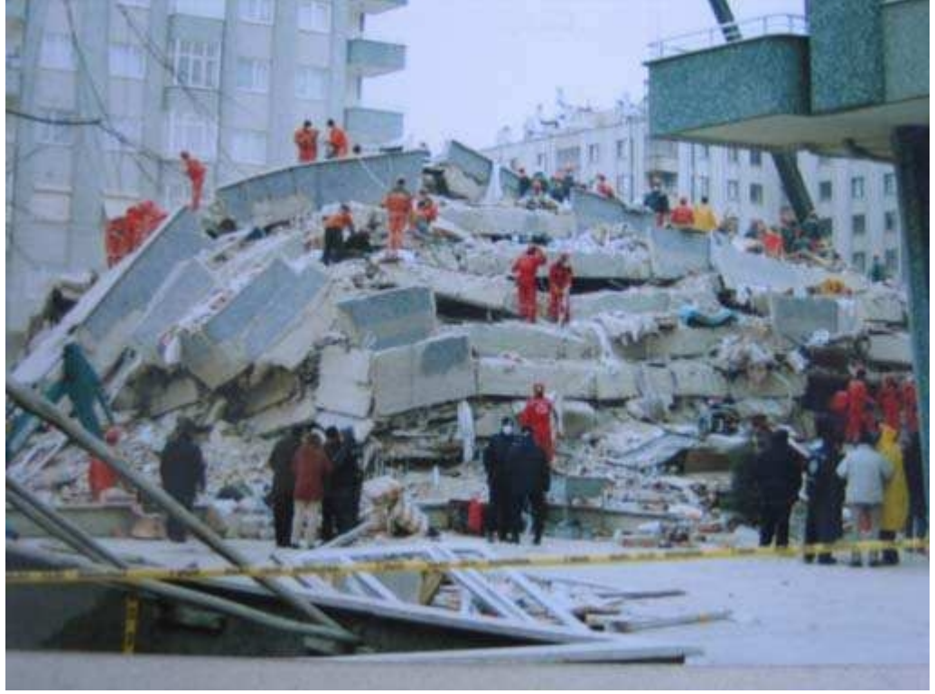
Şekil 4: Betonarme Karkas Yapıda Malzeme, Tasarım, Uygulama Hataları Sonucu Yıkılan Sekiz Katlı Yapı Görünüşü
