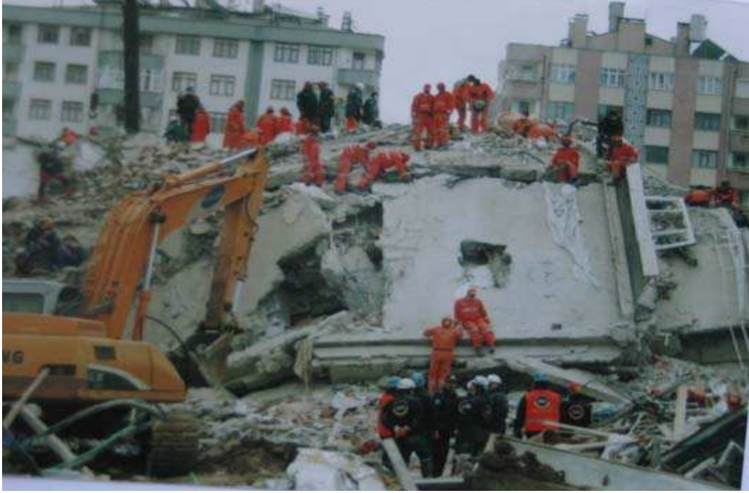
Şekil 5: Yetersiz Denetim ve Kalitesiz Betonarme Yapı
