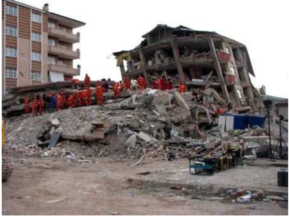
Şekil 8: Sevgi Apartmanı – Van 2011
