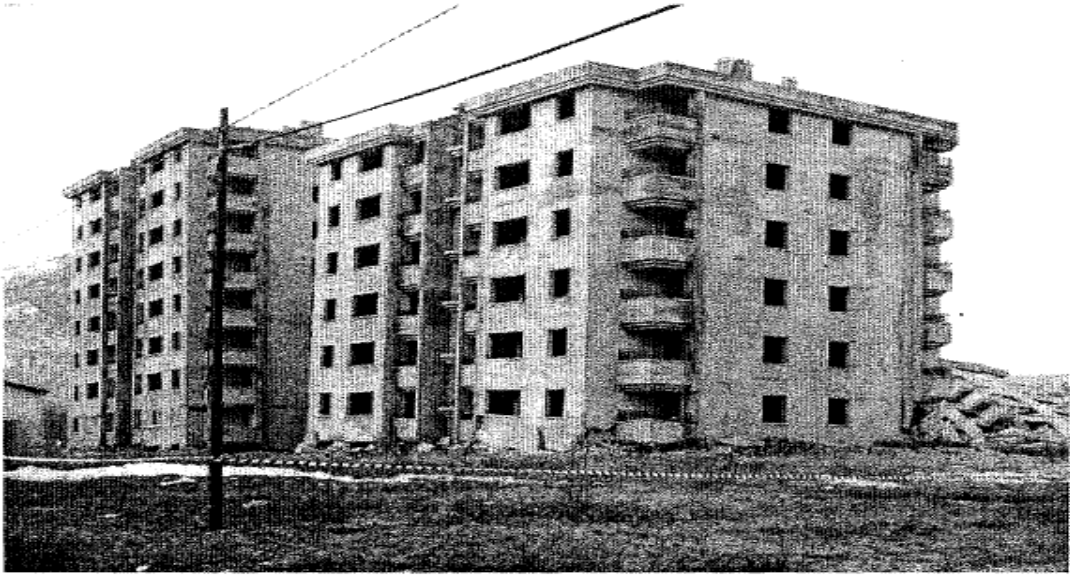
řekil 6: Konut Yapı Kooperatifi İnřaatından Hasar Görüntüsü (3 Katı Yer İçine Çökmüş Bir Bina)
