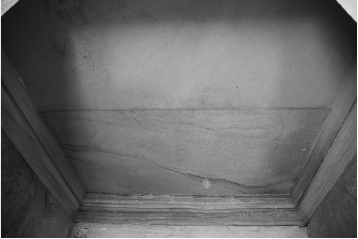
Resim 4.15. Ön odanın iki parça mermer bloğun birleştirilmesiyle oluşan düz çatılı üst yapısı ve tavanın hemen altındaki üç duvarı çeviren profilli çerçeve.
