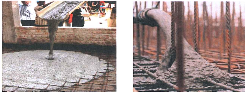
Şekil 2.1. Kendiliğinden yerleşen betonun şantiye ortamında dökümü
