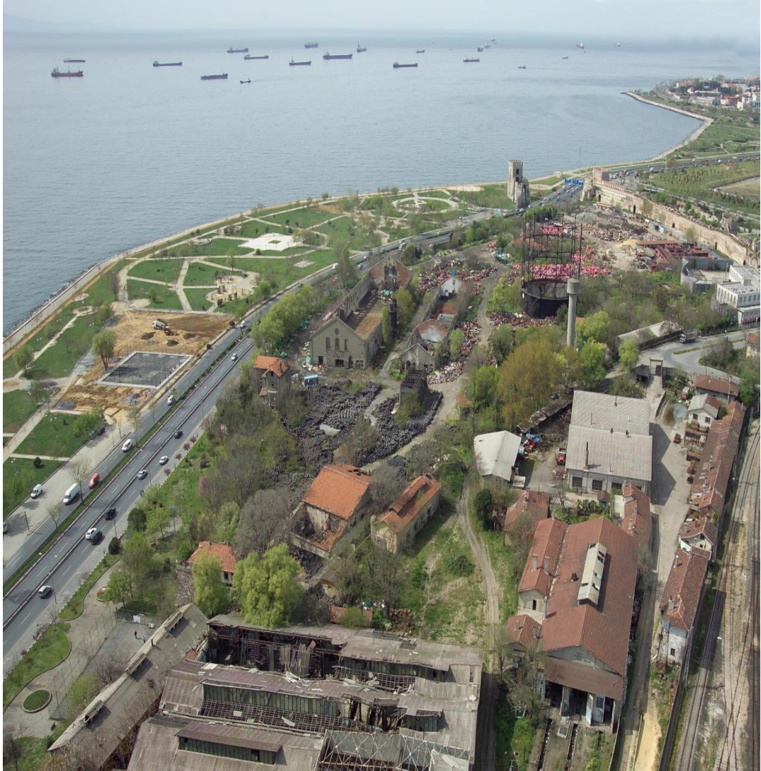
Şekil 4.11 Yedikule Gazhanesi'nden bugüne ulaşan yapılar, demiryolları ve kara surları (Vefkioglu,2009)
