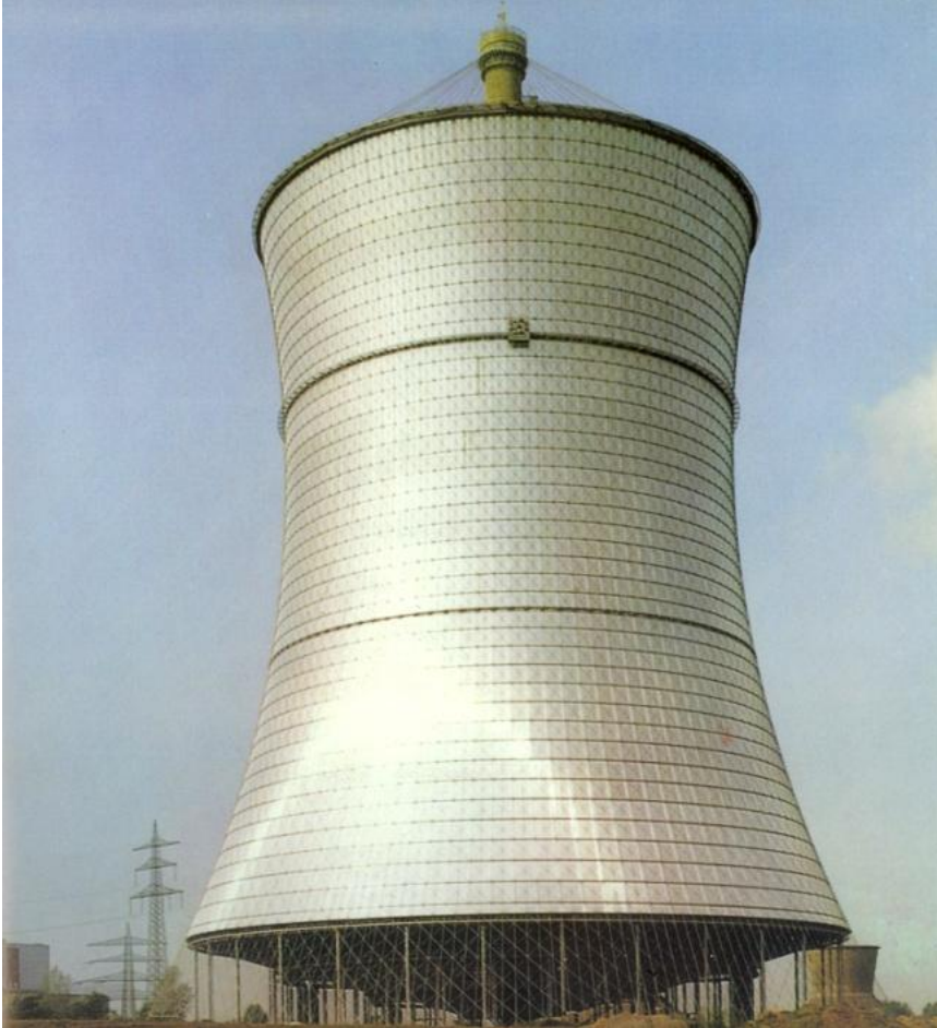
Şekli 3.19 Dış Cephesi Sonradan Tasarlanan Bir Endüstri Yapısı (Url 14)
