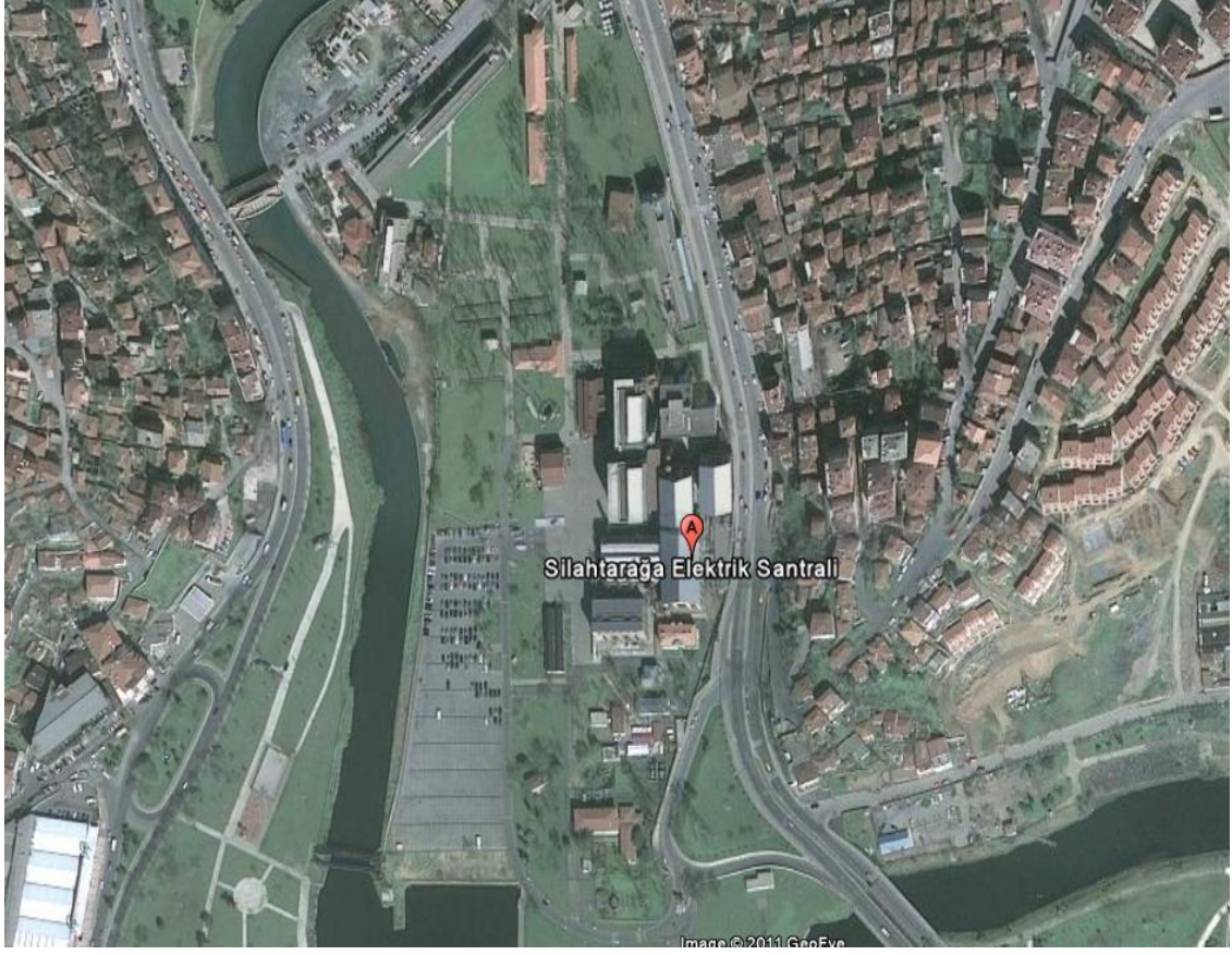
Şekil 3.33 Silahtarğa Elektrik Santrali(Santral İstanbul)'nin Bugünkü Durumu Verilmiştir.
