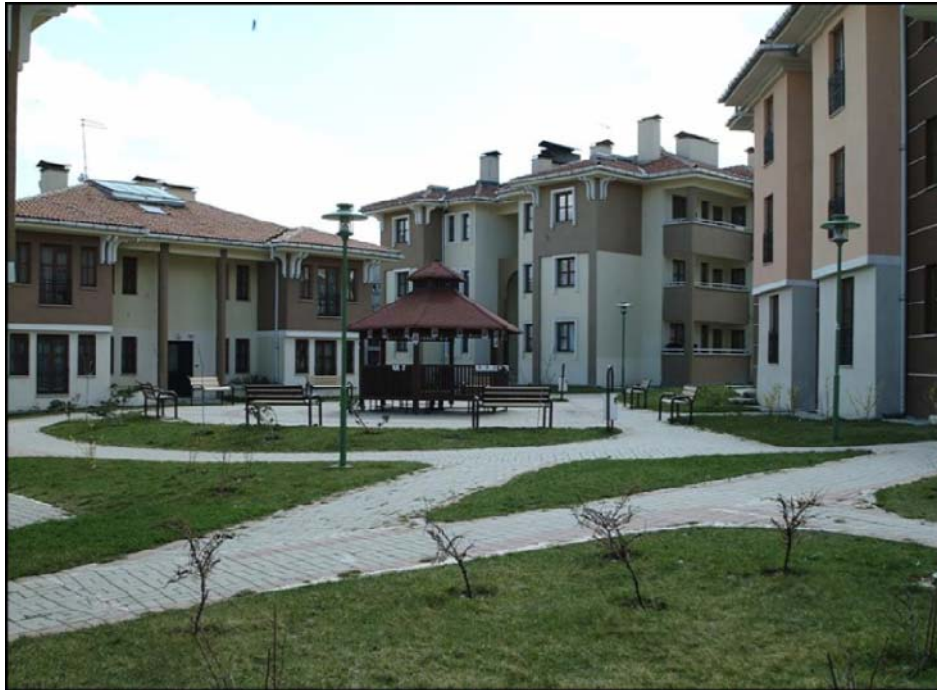
Foto 25 : 1999 Depremleri ( 17 Ağustos Marmara ve 12 Kasım Düzce Depremleri) Sonrası, Depreme Uygun Yapılan Kalıcı Konutlar
