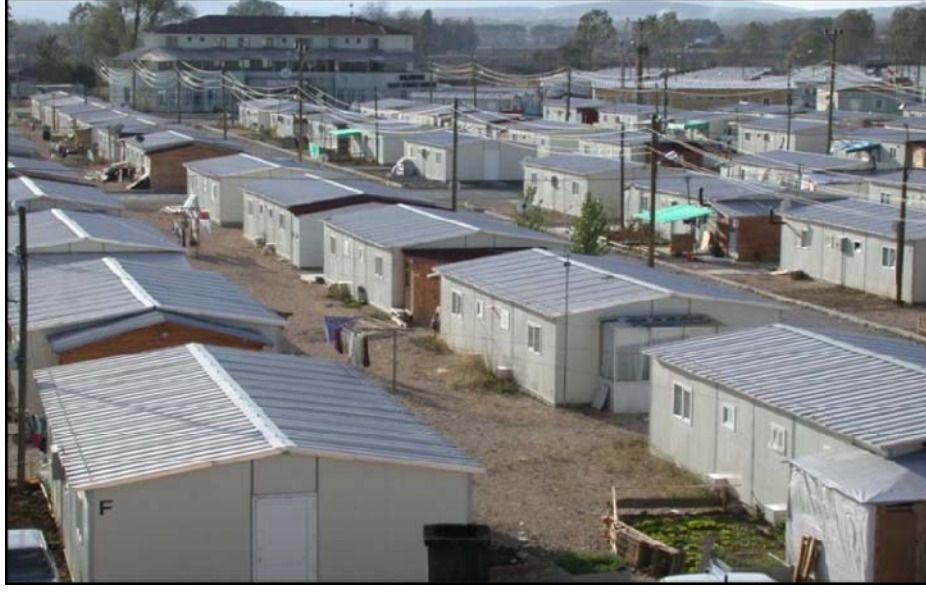
Foto 24 : Bolu’da 1999 Depremleri (17 Ağustos Marmara ve 12 Kasım Düzce Depremleri) Sonrası Kurulan Prefabrik Konutlar
