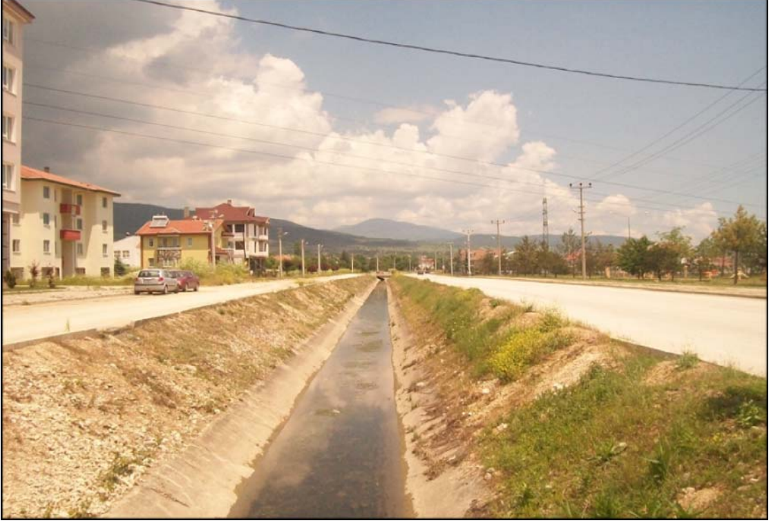
Foto 31 : Bolu Belediyesi'nce Devlet Su İşleri'ne Ait Sulama Kanalı'nın Her İki Yanında Ulaşım Yolu Yapıldığı Görüntüsü
