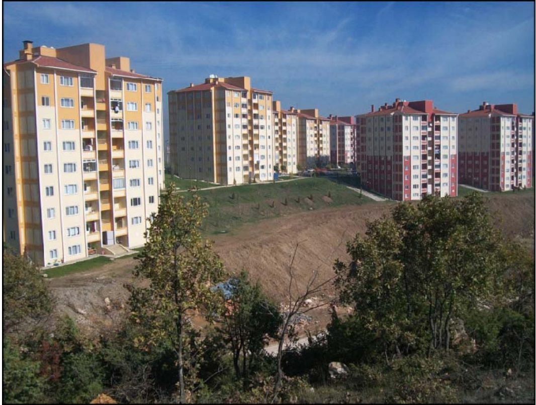
Foto 27 : Kürkçüler Mahallesi'nde 1. Derecede Sağlam Zemînde Yapılan Konutlar
