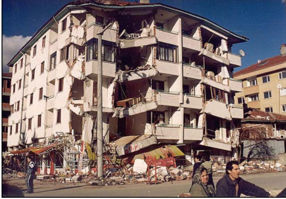
Foto 22 : 1999 Depremlerinde (17 Ağustos Marmara ve 12 Kasım Düzce Depremleri) Yıkılan Bir Bina Görüntüsü
