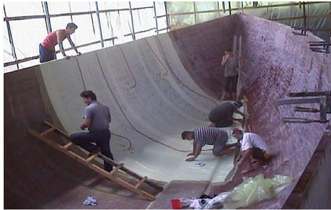
Şekil 3.16 : Tekne iç konstrüksiyonuna elyaf levhaların döşenmesi.
