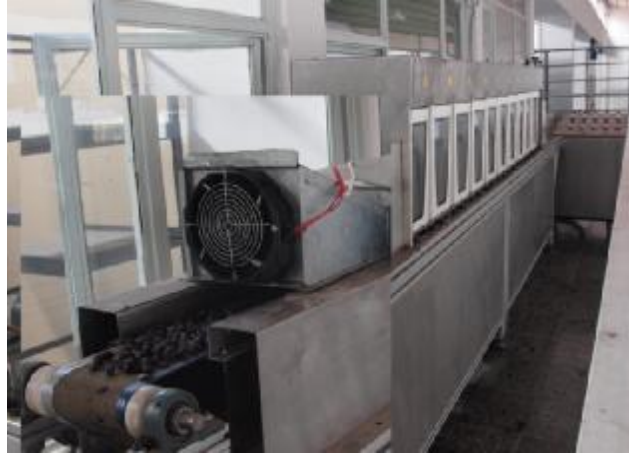
Şekil 3.2. Kurutucu tüneli giriş-çıkış bölümüne yerleştirilmiş fan
