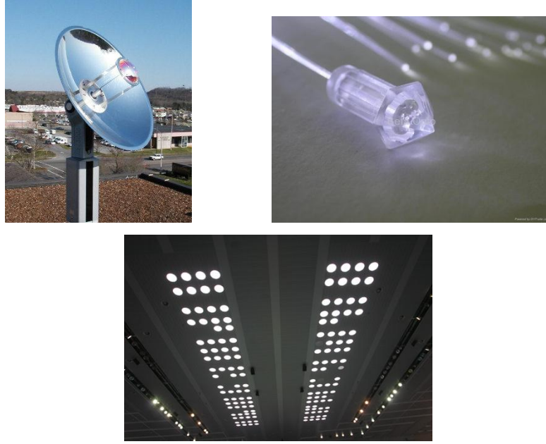
Şekil II.32 Güneş kolektörü ve Fiber optik aydınlatma örneği
