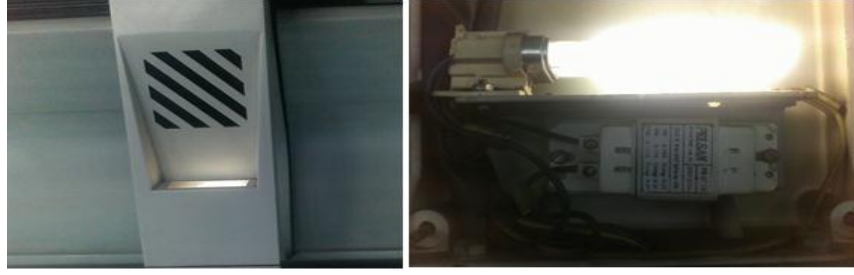
Resim 5.5: Salon 220 V AC aydınlatma armatürü, kompakt floresan ve balastı
