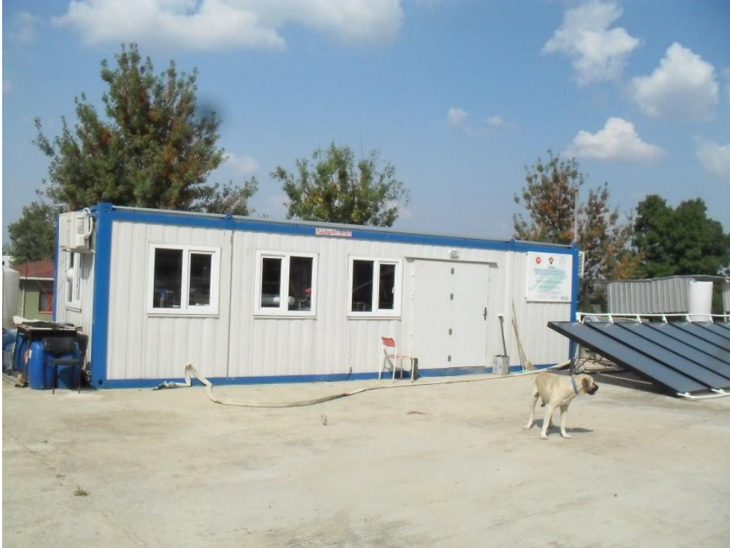
Şekil 2.2 : Pilot tesisin dışarıdan bir görünümü.
