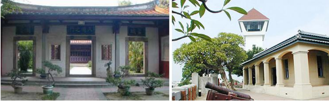
Şekil 3.4 : Tainan'daki tarihi Confucian Temple (Solda) ve Anping Fort (Url-5).
