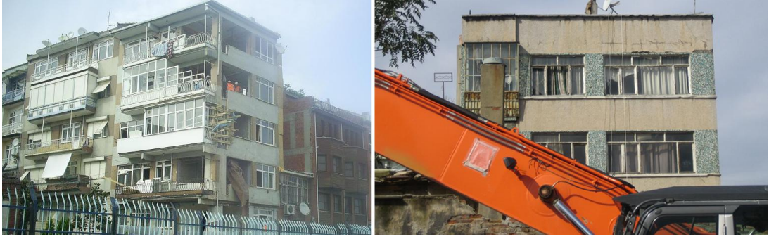
Şekil 5.16 : Marmaray’ dan etkilenen binaları güçlendirme çalışmaları (solda) ve son durumda boşaltılan binalar (sağda)
