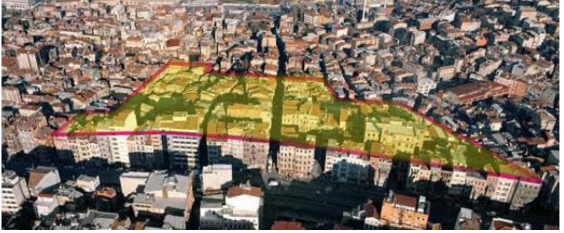
Şekil 4.20 : Tarlabası 1. Etap Yenileme Projesi alanının havadan görünümü (Url-14).
