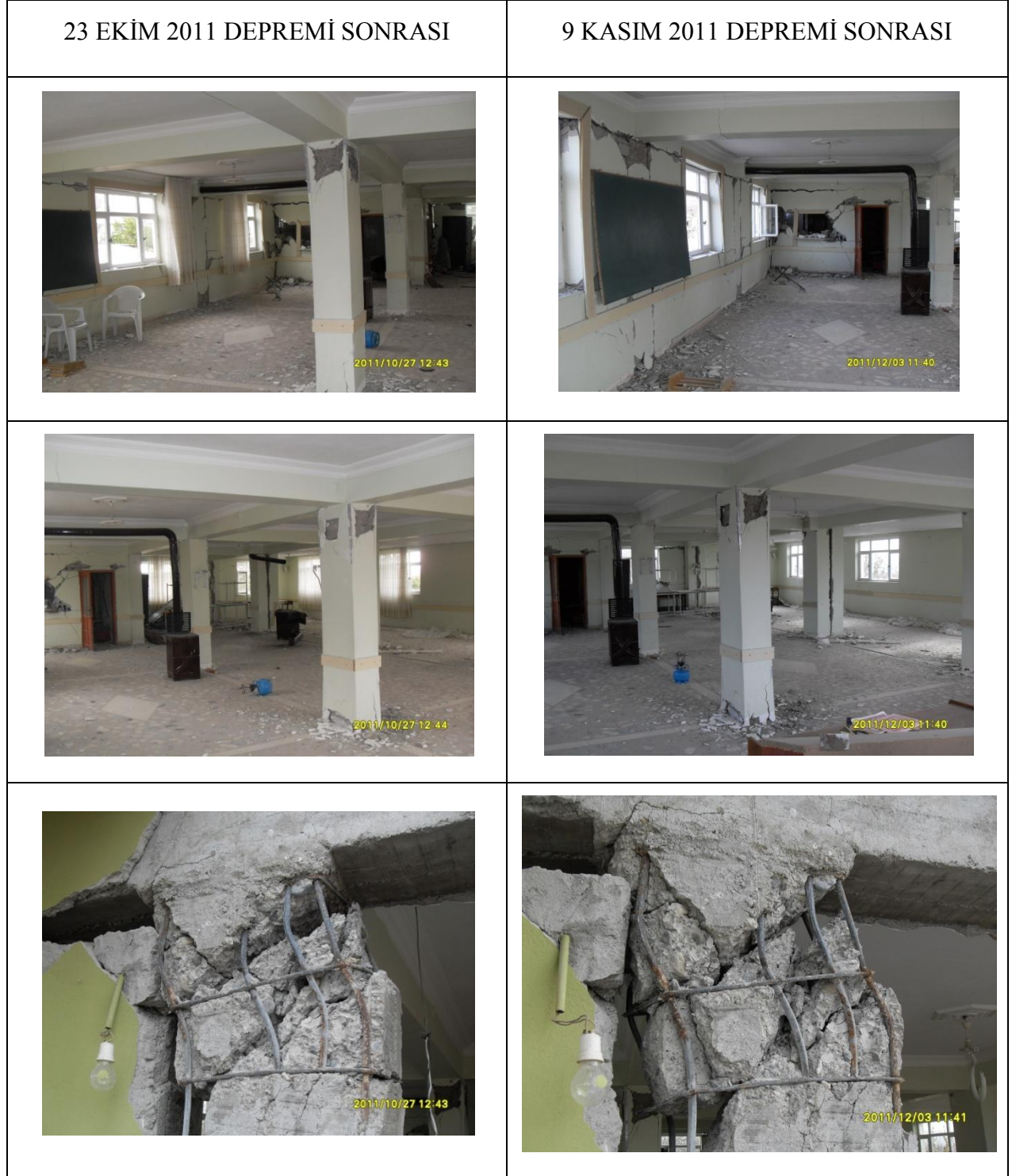
Şekil 5.4 : Binanın iki deprem sonrası karşılaştırmalı fotoğrafları.
