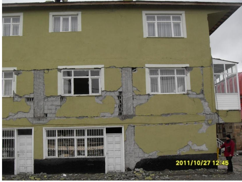
Şekil 5.2 : Alaköy kurs binası, yan cephe fotoğrafı.
