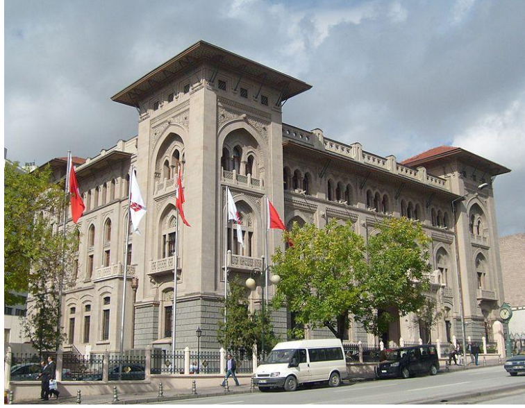
Resim 36. Giulio Mongeri tarafından tasarlanan, ilk Ziraat Bankası Genel Müdürlük Binası, 1925-1929, Ankara
