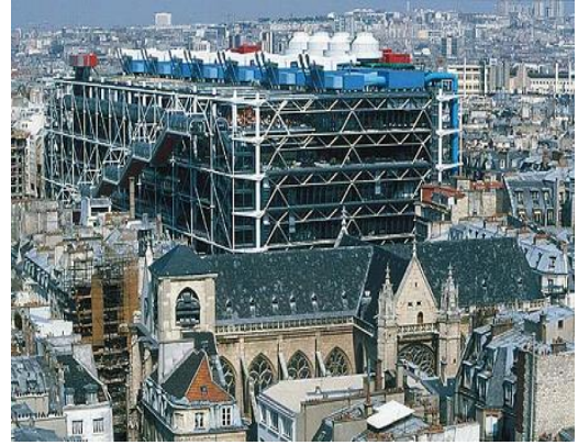
Resim 29. Postmodern mimari yapı tasarımları Pompidou I - Lord Richard Rogers
