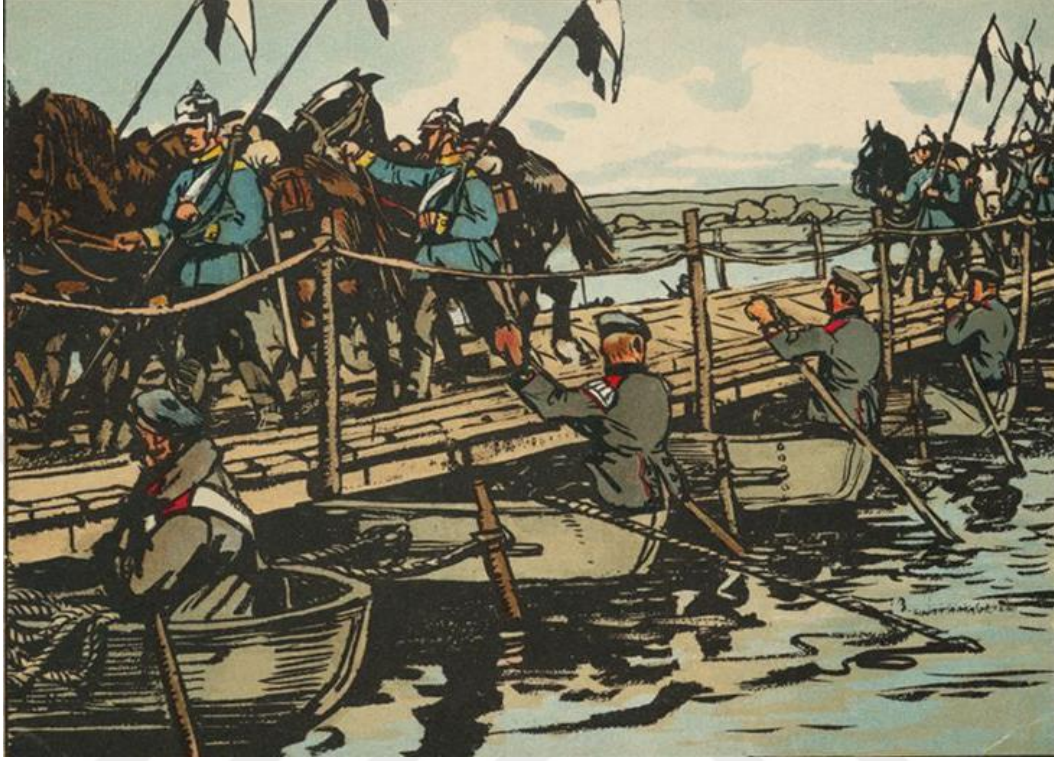
Ek 4: Alman askerlerinin Ren Nehri üzerindeki tombaz köprüden geçişi. 621
