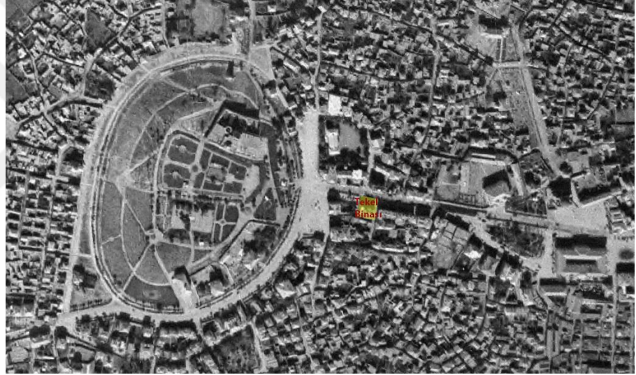
Şekil 6.47. Tekel Binası'nın Konumu, (URL 16).
