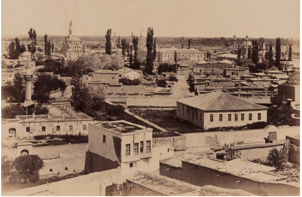
Şekil 5.26. Arka Kısımda Bulunan Çok Kubbeli Yapı Konya Bedesteni Berggren'in Konya Panaroması, (URL 8).
