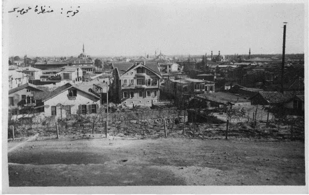
Şekil 5.16. Alaeddin Tepesi eteklerinde bulunan elektrik fabrikası, sağda bacasıyla birlikte görülmektedir, (Odabaşı, 1998).
