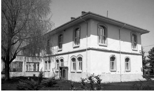
Şekil 6.31. Hara İdare Binası, (URL 17).
