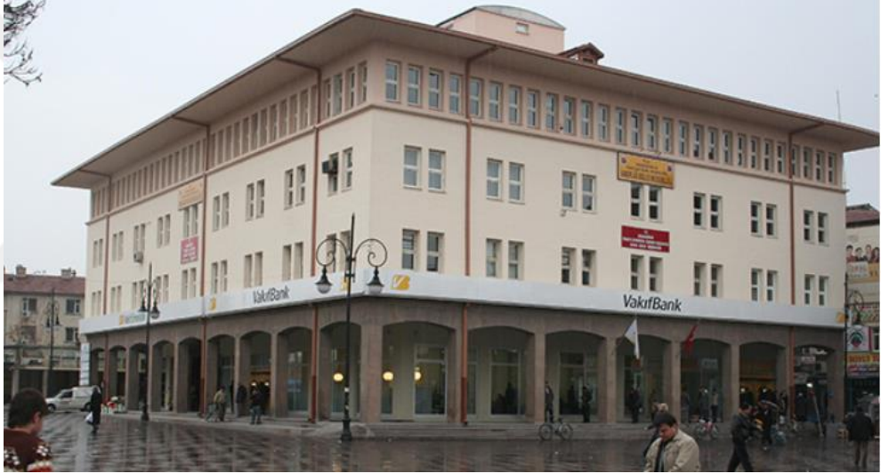
Şekil 6.69. Konya Vakıflar İşhanı Binası, (URL 23).
