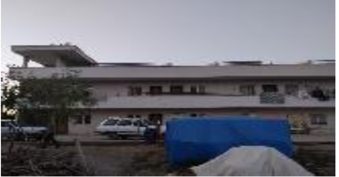
Şekil 6.10 Araştırma alanlarından Adana İli Yüreğir İlçesinde çalışan mevsimlik gezici tarım işçisi hanelerin kaldıkları evler
