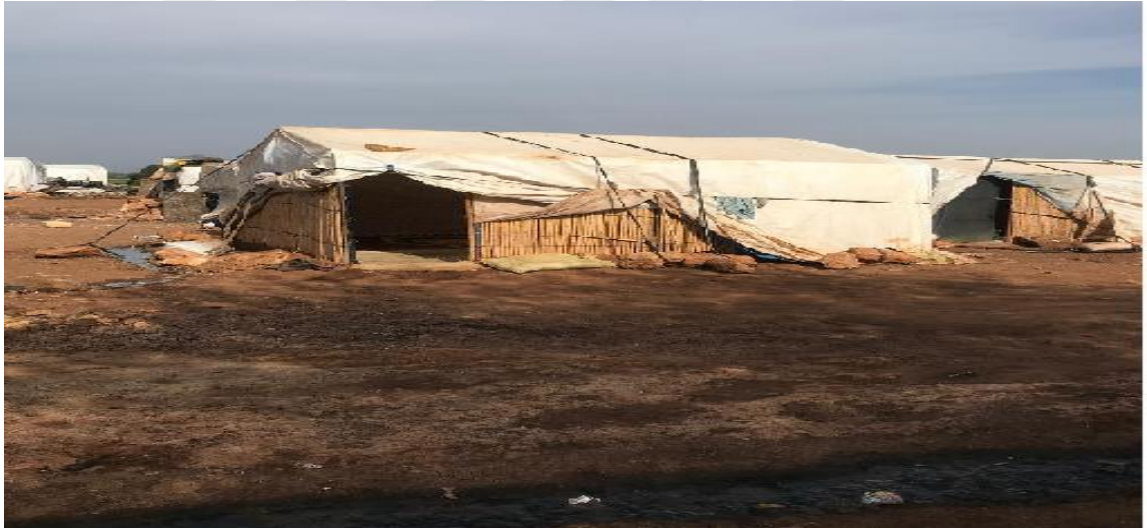
Şekil 6.9 Çadır bölgesinde atık suların tahliyesinde yeterli altyapının olmadığını gösteren bir görünüm
