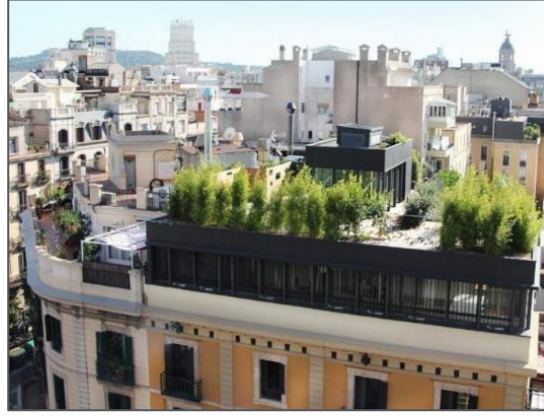
Şekil 3.7. Yeşil çatılı apartman, Barselona (LCT, 2015)
