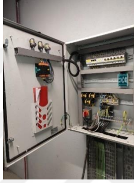
Şekil 3.24. Besleme panosu: filtrelenen enerji bu panadon kabinetlere gider
