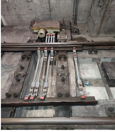
Şekil 3.9. Sol: Bombardier makas motoru sağ: Volstalpine makas motoru
