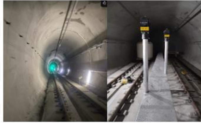
Şekil 3.7. Sol: yeşil sinyal görünümü sağ: buffer stop öncesi tekli kırmızı sinyal
