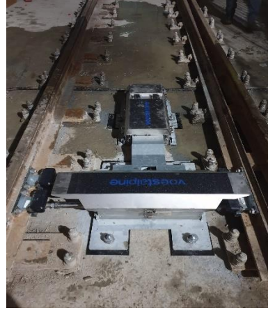
Şekil 3.9. Sol: Bombardier makas motoru sağ: Volstalpine makas motoru
