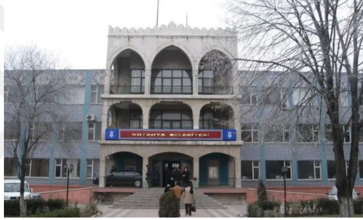
Yıkılan Eski Belediye Binası (Yapım: 1958)
