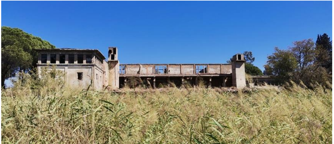
Şekil 3.8. Elektrik santralinin son hali
