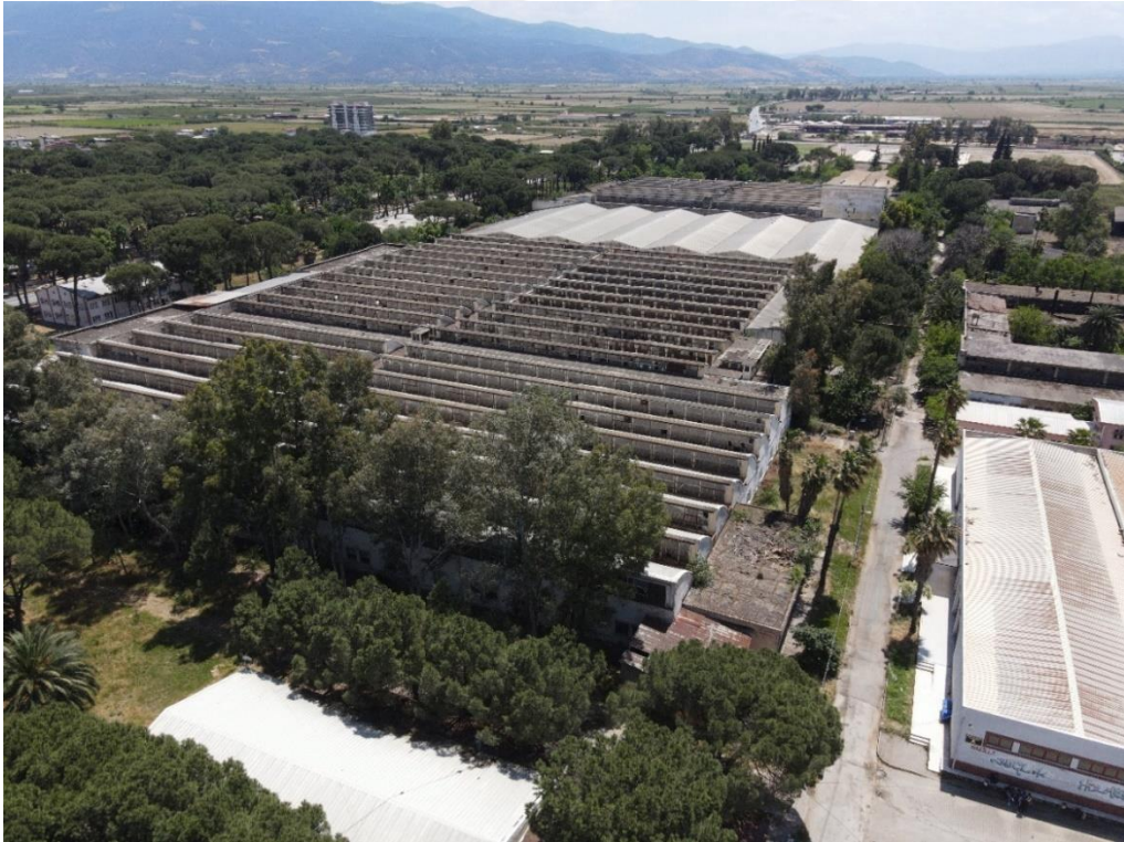
Şekil 3.6. Atıl durumda olan fabrika binaları
