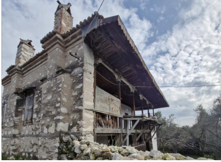
Fotoğraf 36. Yapının Güncel Hali, 2024.
