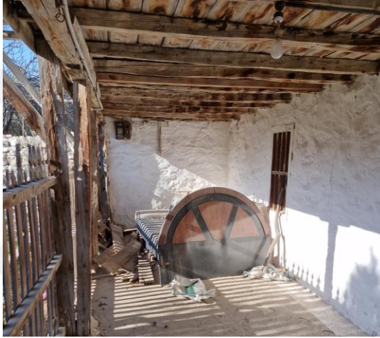
Fotoğraf 40. Zemin Kat Hayat Mekanı, 2024.
