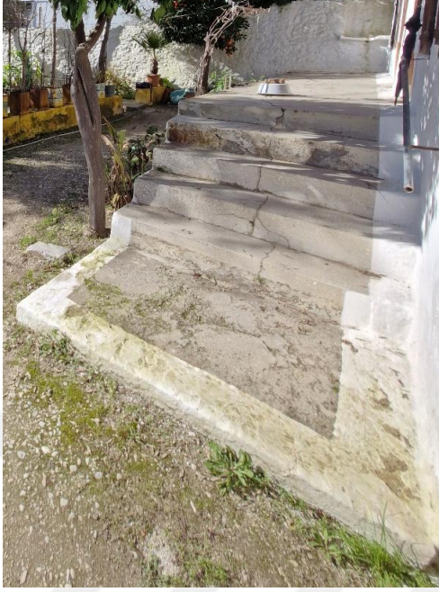
Fotoğraf 12. Hayata Çıkan beton Merdiven.
