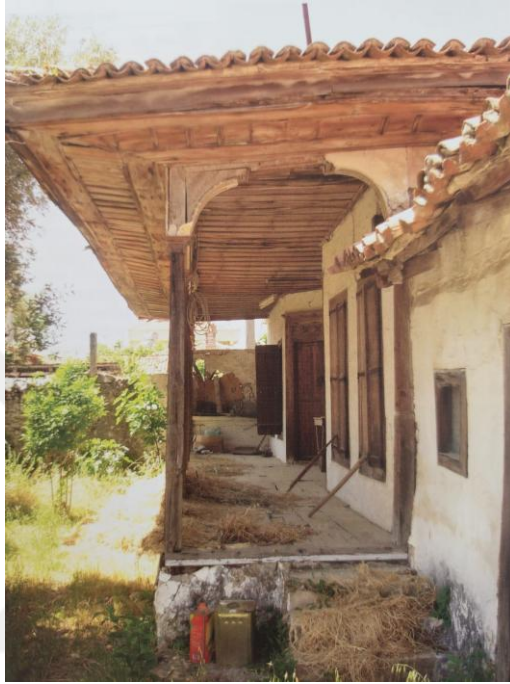
Fotoğraf 59. Proje Öncesi Yapı. (Kıntak, 2014.)
