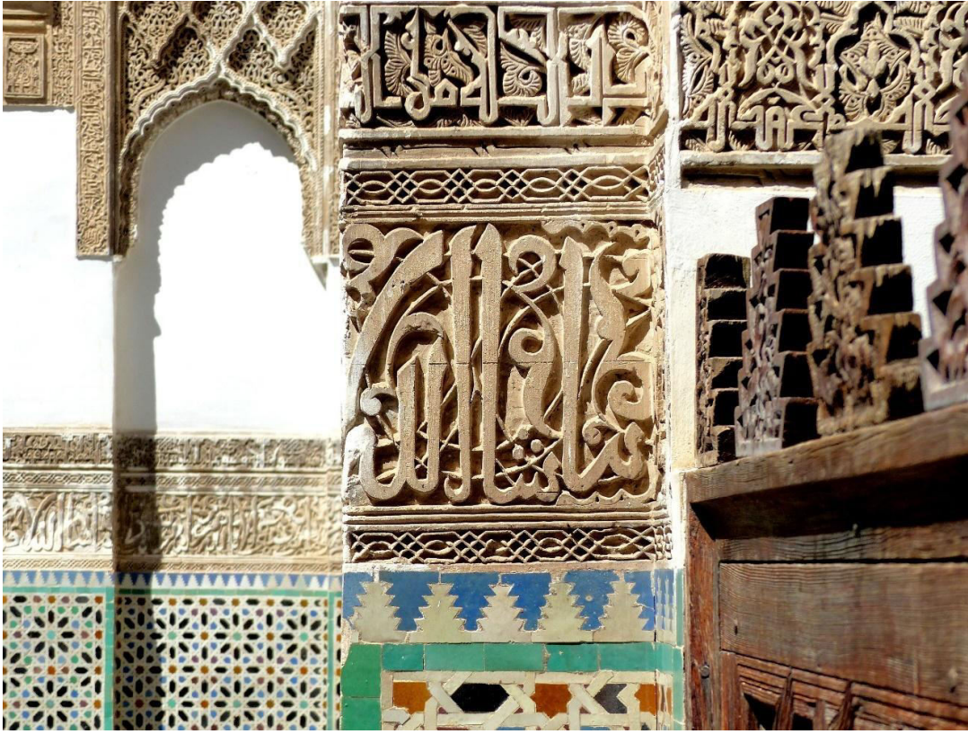
Resim 64: Sıhrîc Medresesinde oymalı alçı kuşaklar örneği
