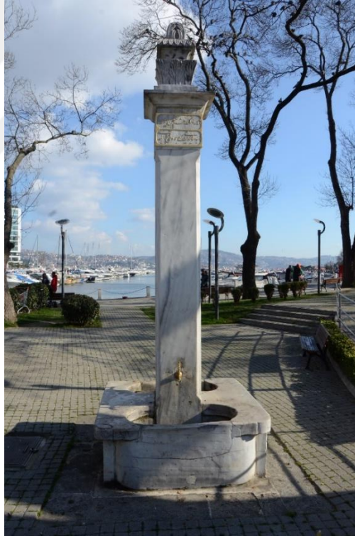
Fotoğraf 73: Tarabya II. Mahmud Çeşmesi Doğu Cephesi Görünüşü
