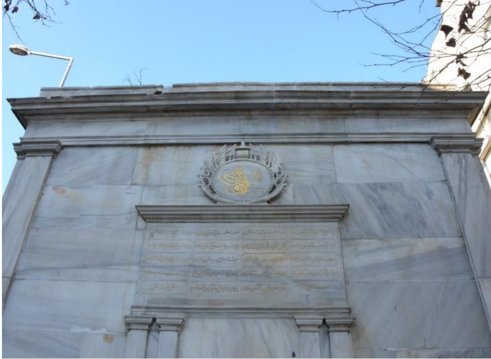
Fotoğraf 124: Sarıyer II. Mahmud Han Çeşmesi Ön Cephe Görünüşü
