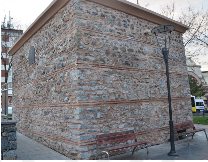
Fotoğraf 87: Kuru Çeşme Su Deposu Kuzey ve Doğu Cephesi
