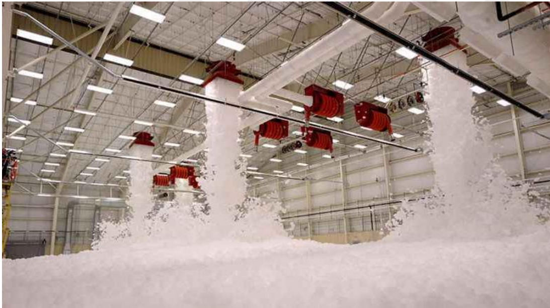
Şekil 2.3. Köpüklü yangın söndürme sistemleri [3].
