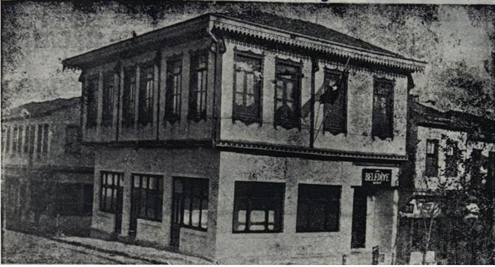
Görsel 4.4. Bilecik Belediye Binası
