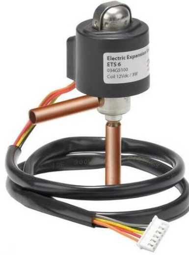
Şekil 3.10. Elektronik genleşme valfi (Anonim i, 2024)
