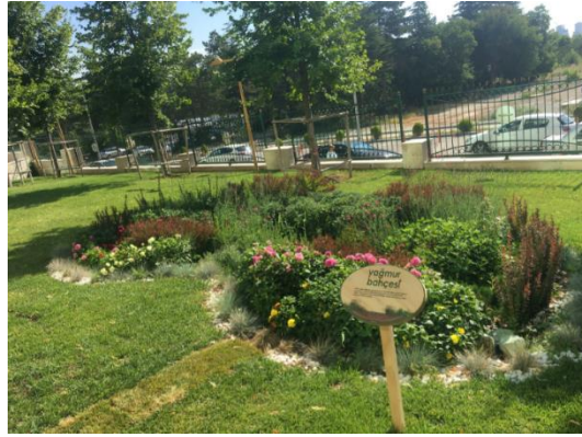
Şekil 25. Çevre ve Şehircilik Bakanlığı bahçesi içinde uygulanan yağmur bahçesi (Anonim 2018)
