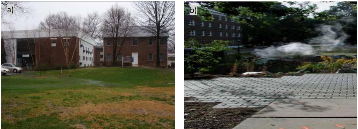
Şekil 18. a) Daleware Üniversitesi kampüsü yağmur bahçesi yapılmadan önceki görseli b) Daleware üniversitesi kampüsü yağmur bahçesi yapıldıktan sonraki görseli
