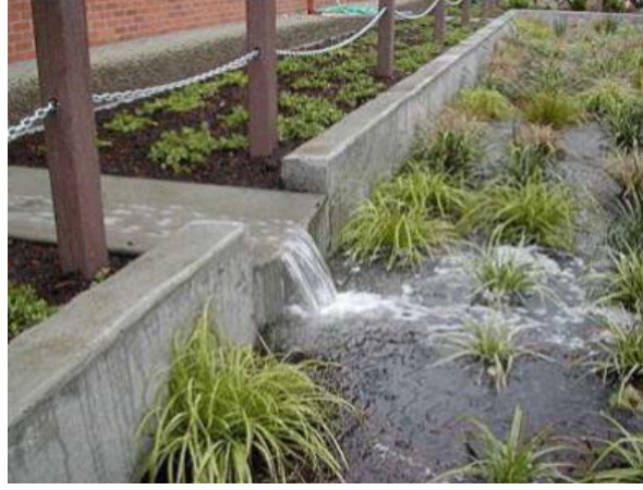
Şekil 15. Portland Oregon’da Mount Tabor Orta Okulu’nda yağmur suyu bahçesinde suyun çatıdan bahçeye taşınması (ASLA 2016).
