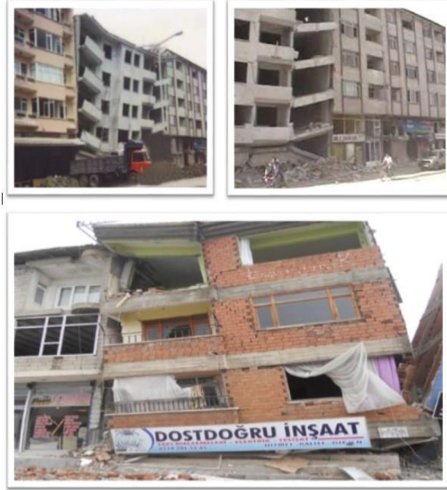
Şekil 1.1. Geçmiş depremlere ait çekiçleme etkisi görüntüleri
