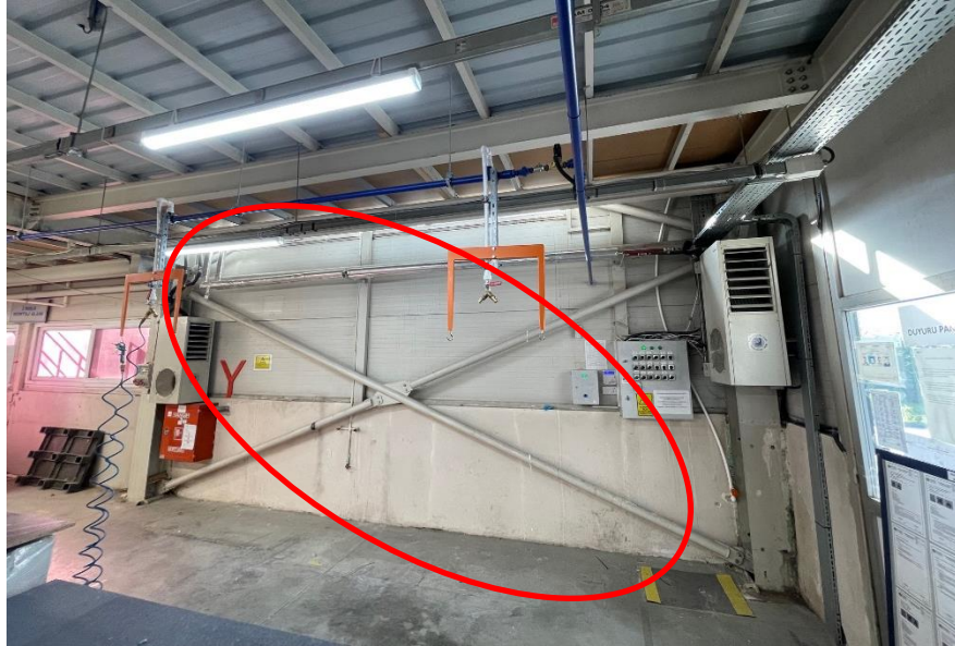
Şekil 3.10. 5S sonrasında montaj alanından kaldırılan merdivensiz durum.
