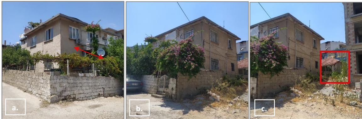
Resim 4.2. Konut 2'nin yazar tarafından çekilen fotoğrafları (a. Güneydoğu cephesi, b. Kuzeydoğu cephesi, c. Yapı arkasındaki depo yapısı)
