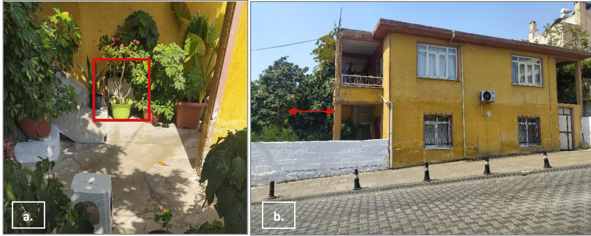
Resim 4.6. Konut 6'nın yazar tarafından çekilen fotoğrafları (a. Açık havalandırma kapağı, b. Kuzey cephesi)
