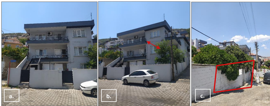
Resim 4.1. Konut 1'in yazar tarafından çekilen fotoğrafları (a. Giriş cephesi, b. Kuzeydoğu cephesi, c. Yapının batısındaki konutla paylaştığı ortak bahçe duvarı)
