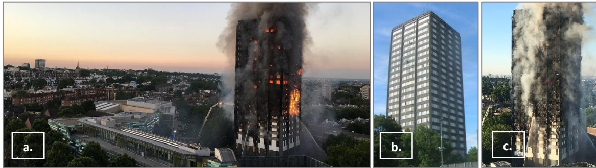
Resim 2.2. Yangın sonucu hasar alan Grenfell Kulesi (a. Yanan Grenfell Kulesi, 04:43, 14 Haziran 2017 (Oxford, 2017a), b. 2009 yılı tadilat öncesi Grenfell Kulesi(Sones, 2009), c. 14 Haziran sabahının erken saatlerinde Grenfell Kulesi. Binaların dışında yangınmış plastik görülebilir (Oxford, 2017b))
