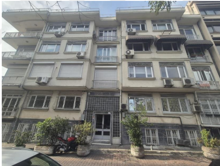
Şekil 6.2. Örnek 1-Ön Cepheden Alınan Cephe Fotoğrafi
